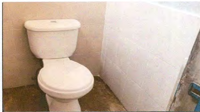
Foto 3: Inodoros instalados en los baños
