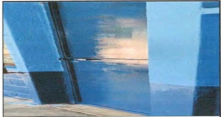
Foto 6: Puerta terminada de pintar
