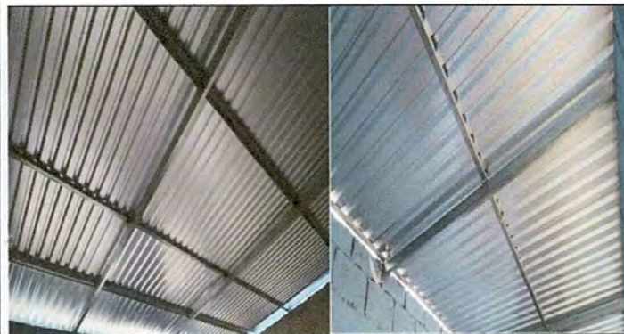
Foto 5: Techo culminadas de las dos aulas, láminas y costaneras puestas
