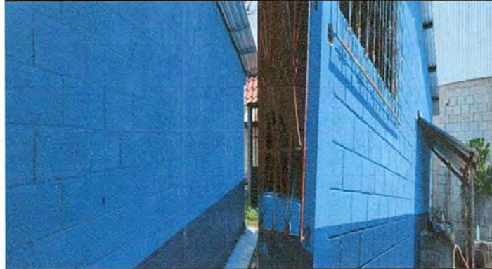
Foto1: Paredes pintadas de la escuela
