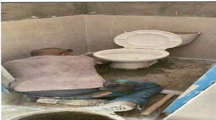
Foto 3: Están instalando los inodoros en los baños
