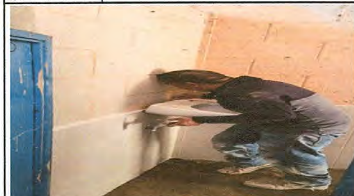
Foto1: colocación del lavamanos en el baño
