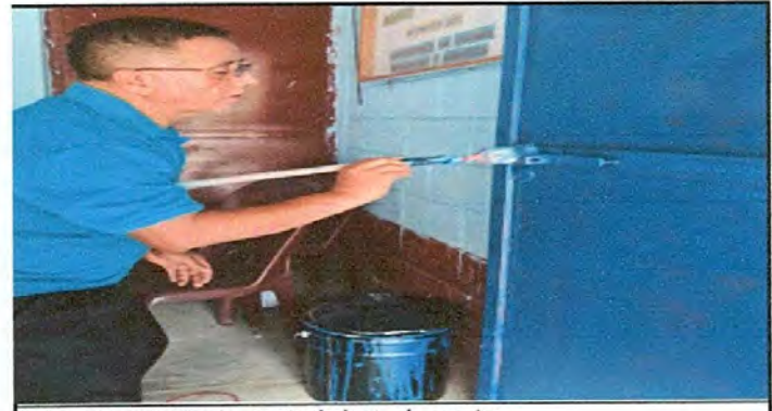
Foto 6: Se está dando mantenimiento de puertas
