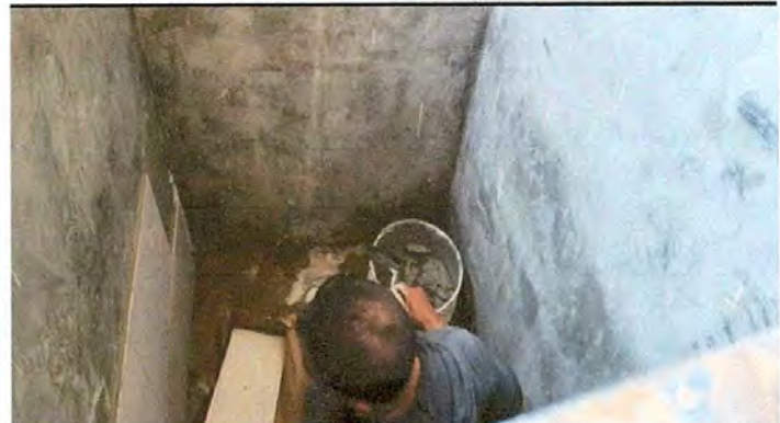
Foto 4: Colocando azulejos en los baños
