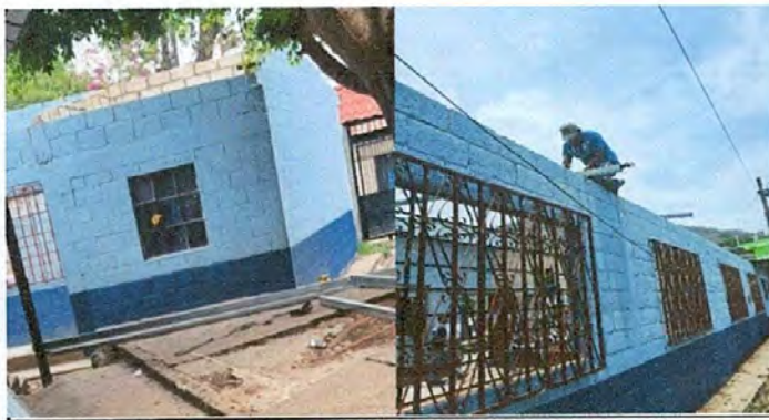
Foto 5: Están colocando las costaneras para el techo de dos aulas y láminas
