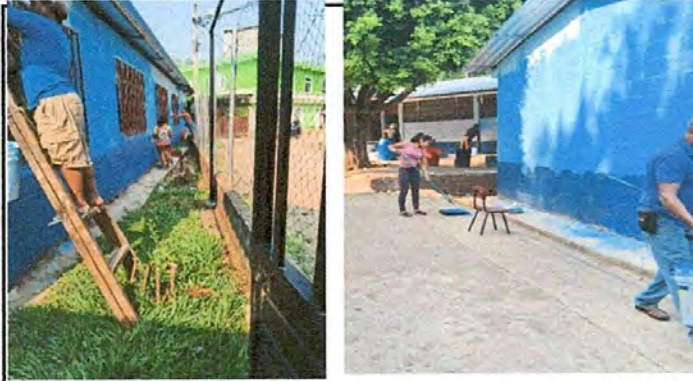
Foto1: Están pintando las paredes de las aulas
