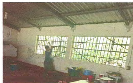
CAMBIO DE ESTRUCTURA DE VENTANAS
