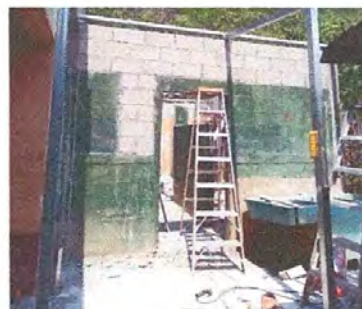
LEVANTADO DE ILADAS DE BLOK
