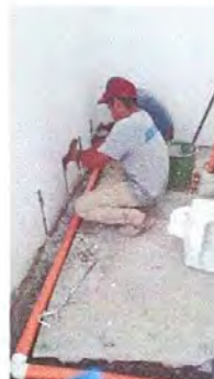
INSTALACION DE TUBERIA PARA MINGITORIO
