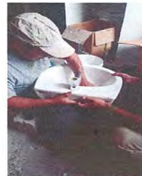
INSTALACION DE LAVAMANOS
