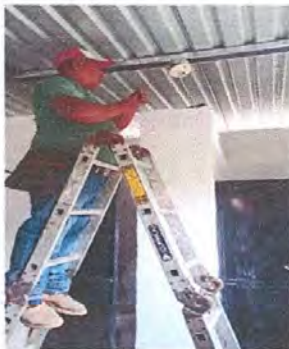
INSTALACION DE ENERGIA ELECTRICA
