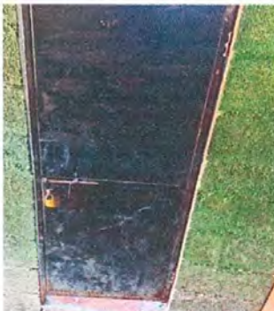
MANTENIMIENTO A PUERTAS SERVICIOS SANITARIOS
