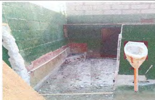
SUTITUCION DE LAVAMANOS
