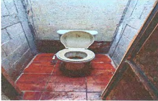
SUSTITUCION DE INODOROS
