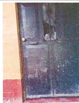
MATENIMIENTO A PUERTAS DE METAL
