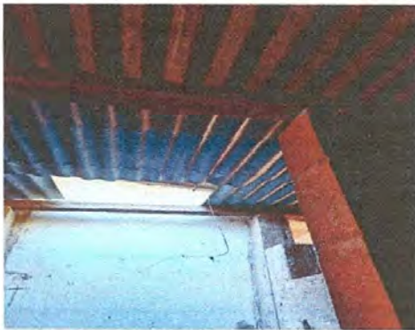
SUSTITUCION DE LAMINA POR LAMINA TROQUELADA
