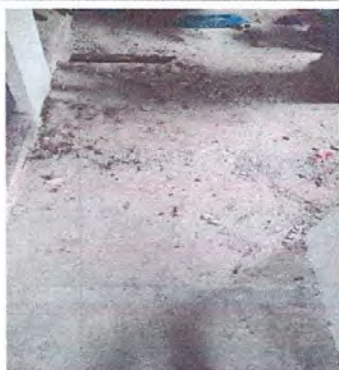
SUTITUCION DE PISO DE TORTA POR PISO DE GRANITO
