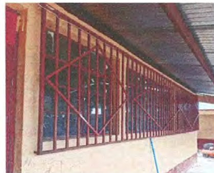
MATENIMIENTO A BALCONES
