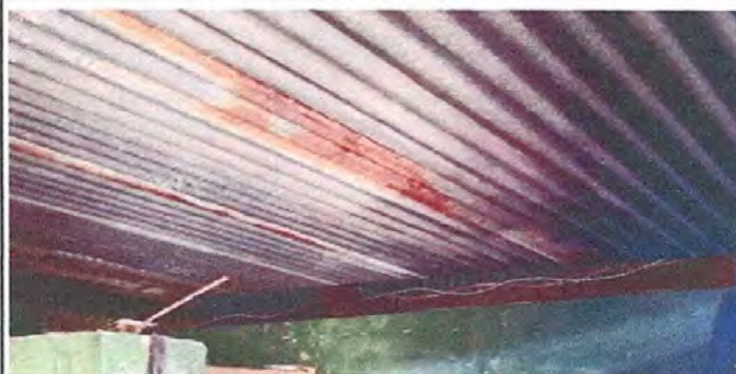
SUSTITUCION DE CABLEADO ELECTRICO
