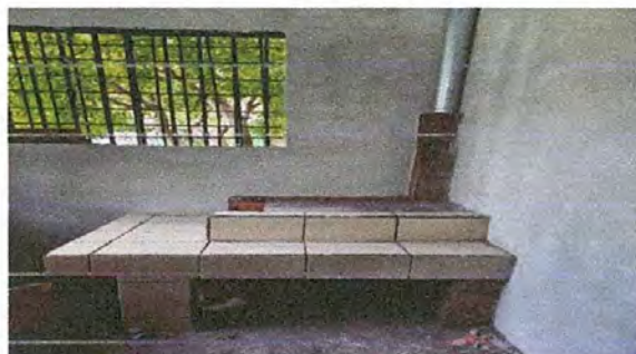
FOTO No. 6 SUSTITUCIÓN DE ESTUFA ARTESANAL CON SU CHIMENEA DE METAL
