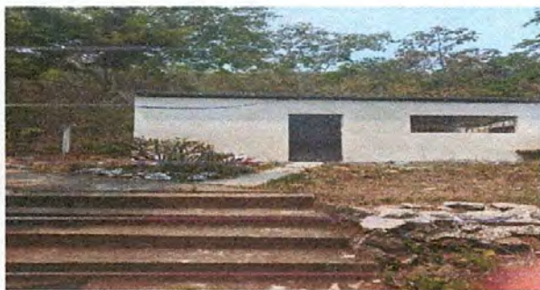
FOTO No. 5 MEJORAMIENTO DE PARED DE COCINA
