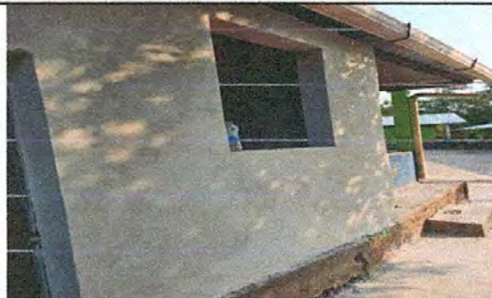
FOTO No. 4 MEJORAMIENTO DE PARED DE COCINA
