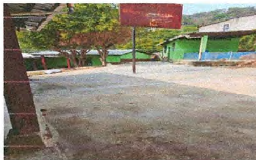
FOTO No.2 REPARACIÓN DE TORTA DE CEMENTO INCONCLUSA EN PATIO ESCOLAR
