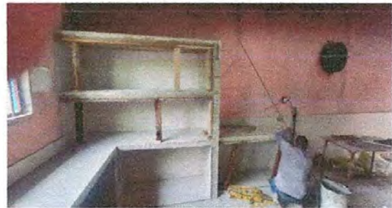
FOTO No. 8 SUSTITUCIÓN DE MESA DE CONCRETO DE 3 METROS CON 3 DIVISIONES CON AZULEJO .
