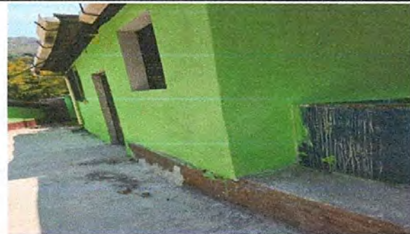
FOTO No. 10 SUSTITUCIÓN DE PINTURA DE PARED DE EXTERIOR COCINA.
