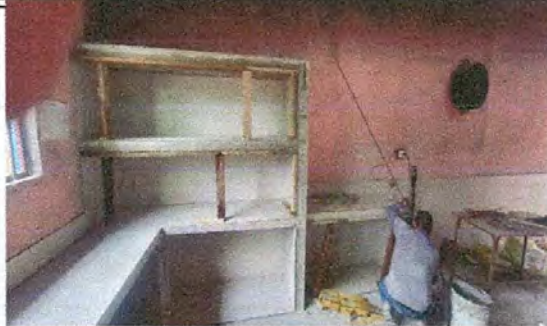
FOTO No. 7 SUSTITUCIÓN DE ESTANTE DE CONCRETO .
