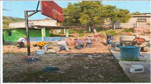
FOTO No.2 REPARACIÓN DE TORTA DE CEMENTO INCONCLUSA EN PATIO ESCOLAR
