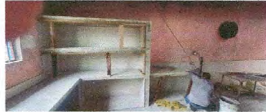
FOTO NO. 8 SUSTITUCIÓN DE MESA DE CONCRETO CON AZULEJO
