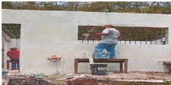
FOTO No. 5 MEJORAMIENTO DE PARED DE COCINA
