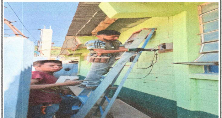
Foto 2: Sustitución del tendido eléctrico en línea principal y cajas de apagadores
