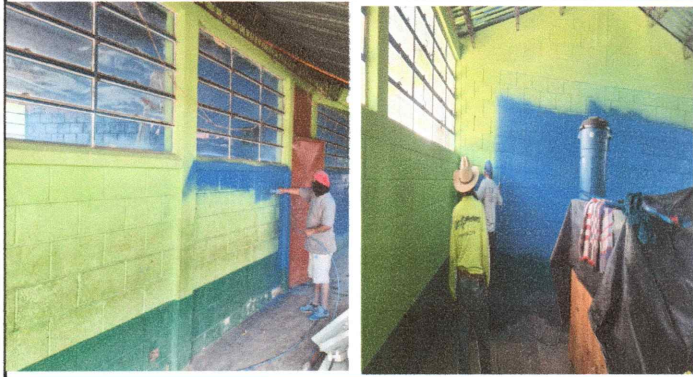
Foto1: Sustitución de pintura interior y exterior del edificio escolar
