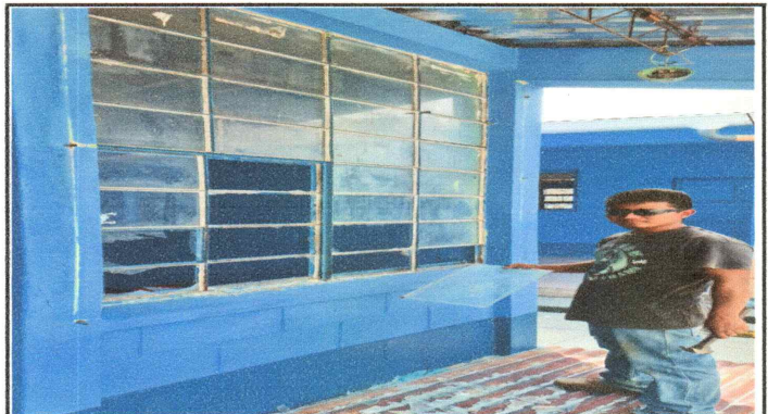
Foto 4: Sustitución de vidrios de ventanales y soldadura
