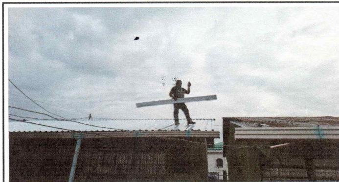
Foto 5: Sustitución de lámina, por lámina troqueladaaluzinc calibre 26
