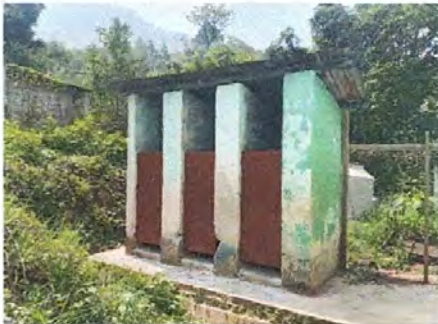
Foto 5. Sustitución de puertas de sanitarios.
