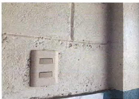
Foto 11. Sustitución de interruptores en aulas
