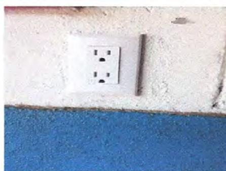
Foto 12. Sustitución de tomacorrientes en aulas
