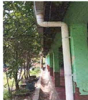
Foto 6. Sustitución de canaletas y caídas de agua.
