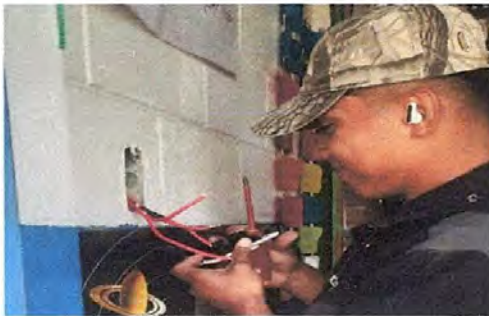
Foto 11. Sustitución de interruptores en aulas
