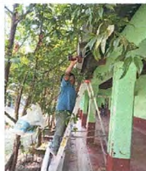
Foto 6. Sustitución de canaletas y caídas de agua.
