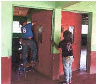
Foto 9. Mantenimiento a 8 puertas de aulas y 1 de baño
