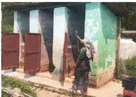
Foto 5. Sustitución de puertas de sanitarios.
