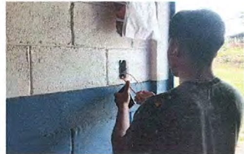
Foto 12. Sustitución de tomacorrientes en aulas
