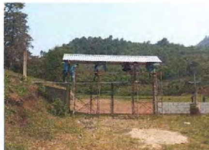
Foto 2. Sustitución y colocación de techo para los portones de entrada principal de la escuela y salida a la cancha de fútbol.
