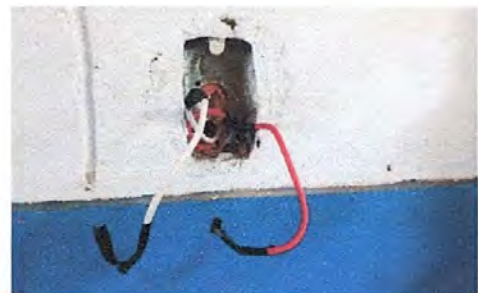
Foto 12. Sustitución de tomacorrientes en aulas
