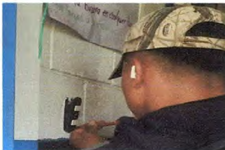
Foto 11. Sustitución de interruptores en aulas
