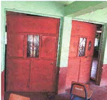
Foto 9. Mantenimiento a 8 puertas de aulas y 1 de baño
