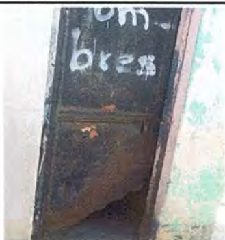
Foto 5. Sustitución de puertas de sanitarios.
