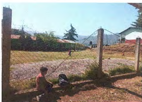
Foto 3. Reparación de muro perimetral con hiladas de block, tubos galvanizados y malla metálica.
