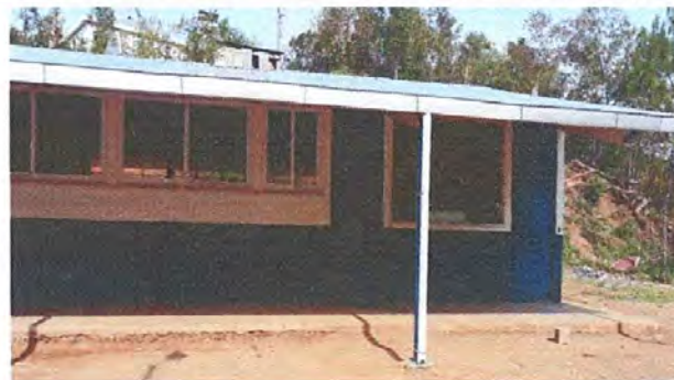
Foto 8 : Instalación de canalón lámina aluzinc.
