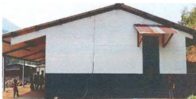
Foto 6: Pintura en muros exteriores e interiores
