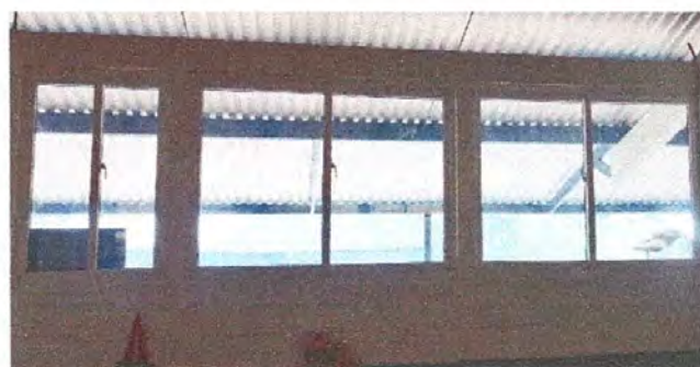
Foto 4: Sustitución de ventanas
