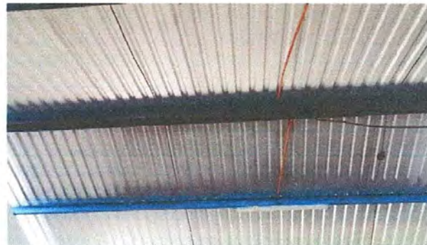
Foto 2: Mantenimiento de estructura de soporte
