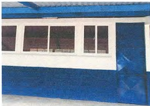
Foto 7: Mantenimiento a puerta estructura de metal
