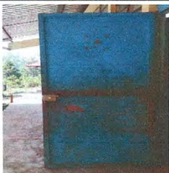
Foto 3: Sustitución de chapa
