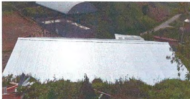
Foto1: Sustitución de lámina troquelada
