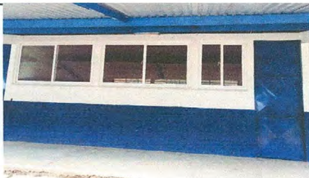
Foto 5: Pintura en muros exteriores e interiores
