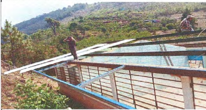
Foto1: Sustitución de lámina troquelada
