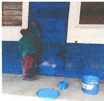
Foto 7: Mantenimiento a puerta estructura de metal
