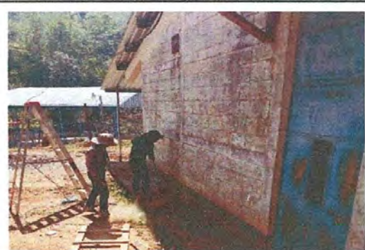
Foto 6: Pintura en muros exteriores e interiores
