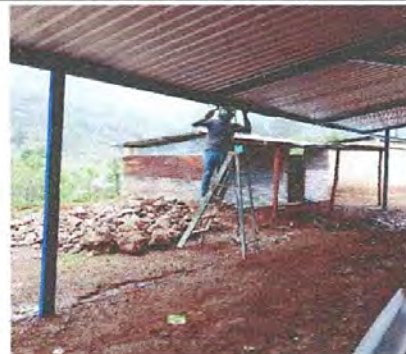
Foto 8: Instalación de canalón lámina aluzinc.
