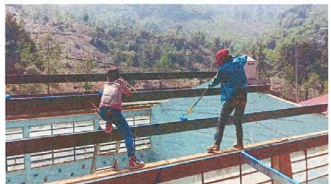
Foto 2: Mantenimiento de estructura de soporte
