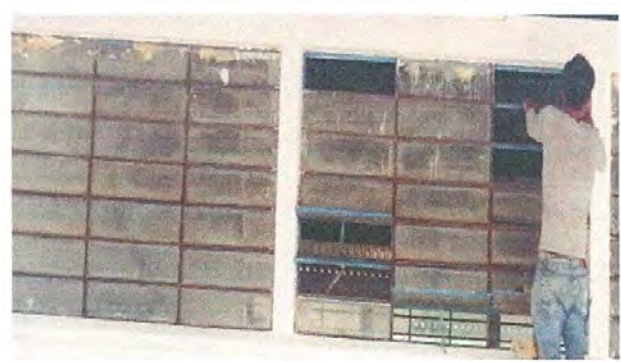
Foto 4: Sustitución de ventanas
