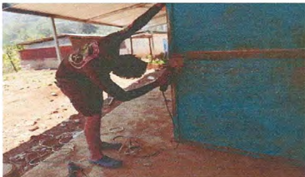
Foto 3: Sustitución de chapa
