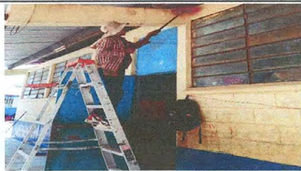
Foto 5: Pintura en muros exteriores e interiores
