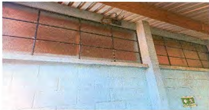
Foto 7. sustitucion de estructura de metal de ventanas.
