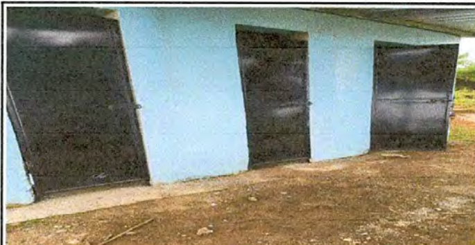
Foto 4: sustitución de puerta.
