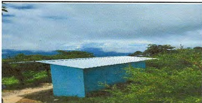
Foto 5. Sustitución de lámina por lámina troquelada
