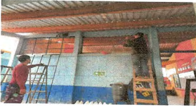
Foto 7. sustitucion de estructura de metal de ventanas.
