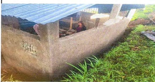
Foto 1. Repello de muro interior y exterior en cocina
