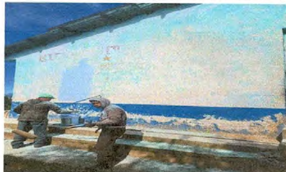
Foto 6. pintura de muros interiores y exteriores
