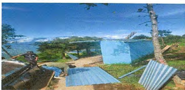
Foto 5. Sustitución de lámina por lámina troquelada
