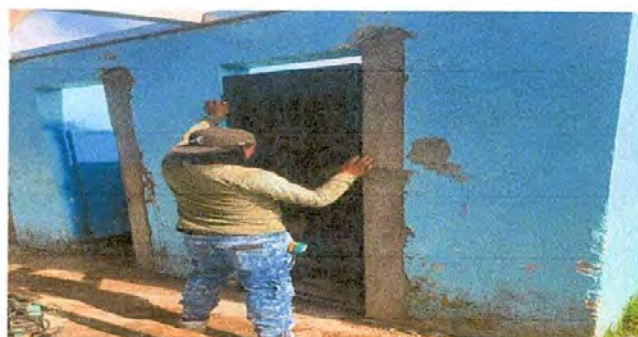
Foto 4: sustitución de puerta.
