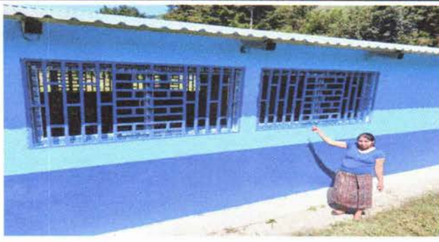
Foto 6: La pintura en paredes exteriores está totalmente finalizada.
