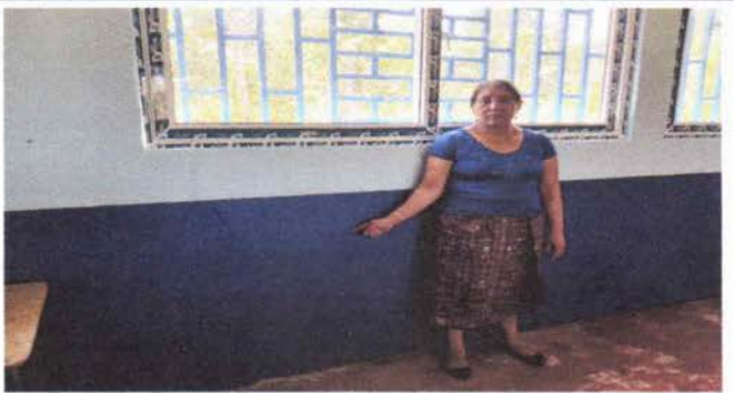
Foto 5: La pintura en paredes interiores está totalmente finalizada.
