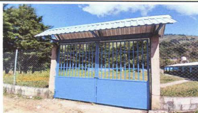
Foto 8: El techo del portón esta totalmente instalado para protegerlo de la interperie.
