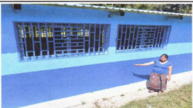
Foto 9: Reparación de repello en paredes exteriores totalmente finalizado.
