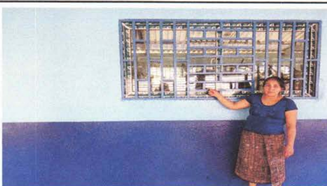
Foto 4: Los balcones están cambiados en su totalidad.
