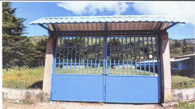
Foto 7: Mantenimiento al portón totalmente finalizado.
