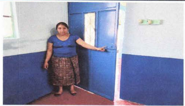
Foto 2: Las chapas de las puertas están cambiadas en su totalidad.
