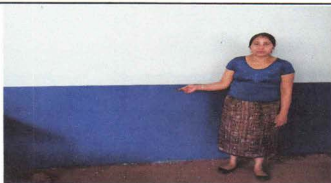
Foto 10: Reparación de repello en paredes interiores esta totalmente finalizado.
