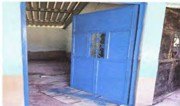
Foto1: Las puertas de las aulas estan en proceso de pintarlas.
