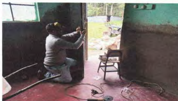
Foto 2: Las chapas de las puertas se encuentran en proceso de cambiarlas.
