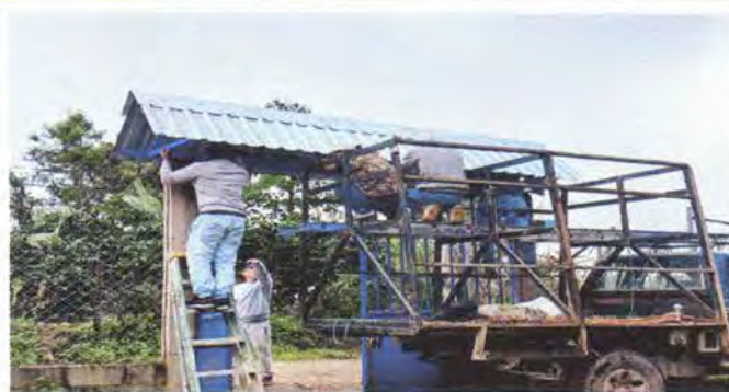
Foto 8: El techo del portón está en proceso de instalación, para protegerlo de la interperie.
