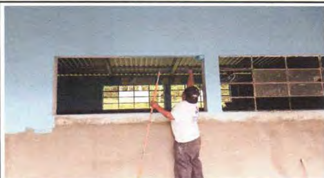
Foto 3: Las ventanas de las aulas estan en proceso de cambiarlas
