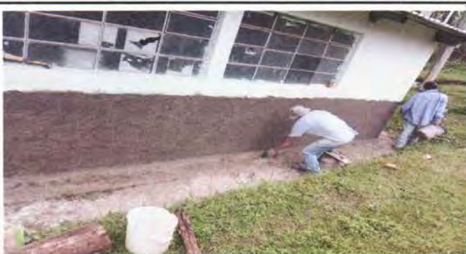
Foto 9: Reparación de repello en paredes exteriores en proceso.
