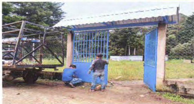
Foto 7: Mantenimiento al portón en proceso.
