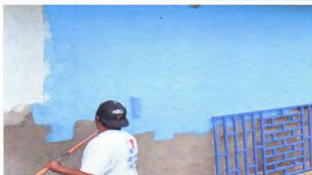
Foto 5: La pintura en paredes interiores esta en proceso.
