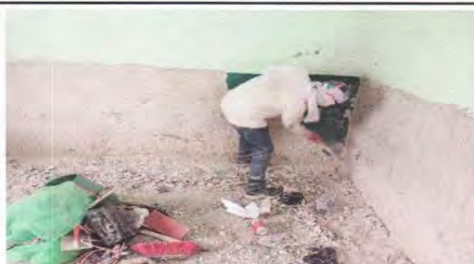
Foto 10: Reparación de repello en paredes interiores en proceso.
