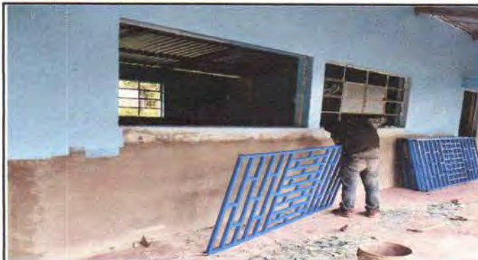
Foto 4: Los balcones estan en proceso de cambiarlos
