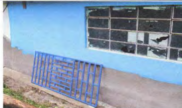
Foto 6: La pintura en paredes exteriores esta en proceso.
