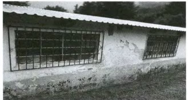
Foto 6: La pintura en paredes exteriores esta deteriorada.
