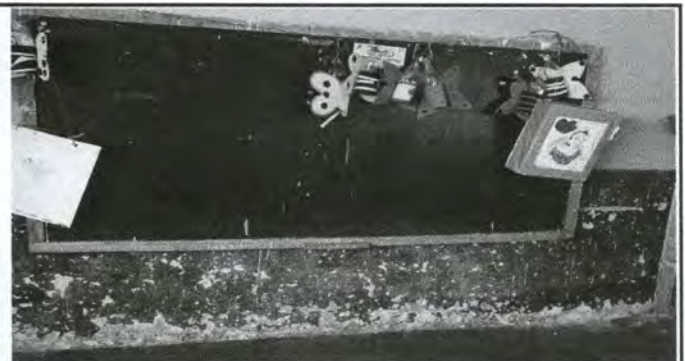
Foto 4: Reparación de repello en mal estado, en la parte interior de las aulas, bodega y dirección.
