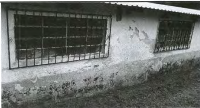
Foto 3: Reparación de repello en mal estado, en la parte exterior de las aulas, bodega y dirección.
