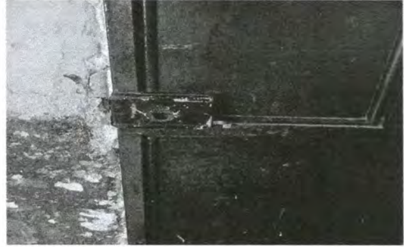
Foto 2: Las chapas de las puertas se encuentran inservibles.
