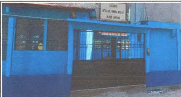
Foto 5: Mantenimiento a portones de metal.
