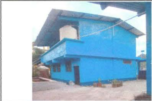
Foto 15: Repellado de paredes de un aul.
