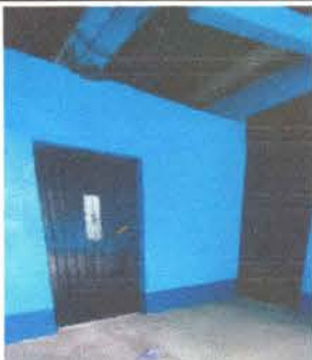
Foto 2: Manteniientos a puertas de metal de aulas.
