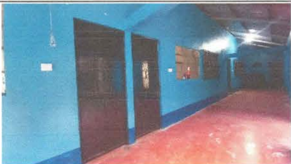
Foto 3: Pintura en muros exteriores e interiores.
