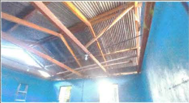
Foto 9: Reparación de sistema eléctrica.
