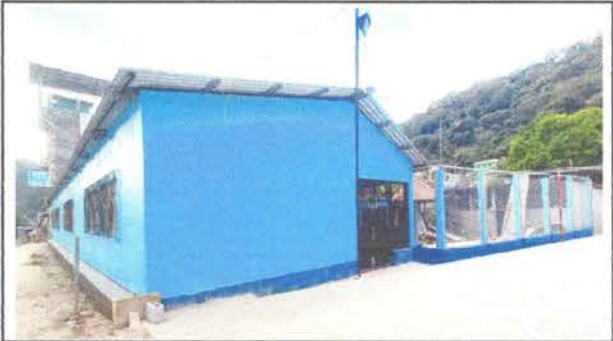
Foto13: Reparación de repello en paredes.
