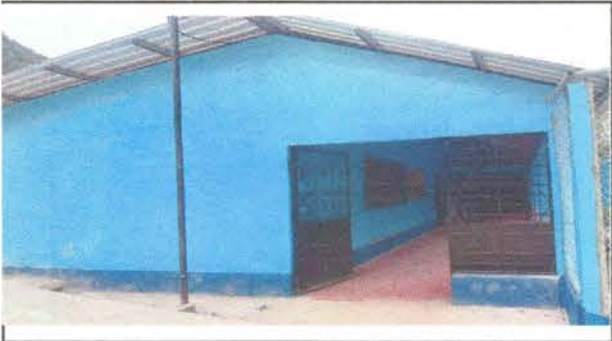
Foto 14: Reparación de repello en paredes.
