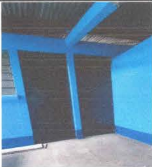
Foto1: Manteniientos a puertas de metal de aulas.
