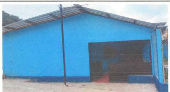
Foto 6: Mantenimiento a portones de metal.
