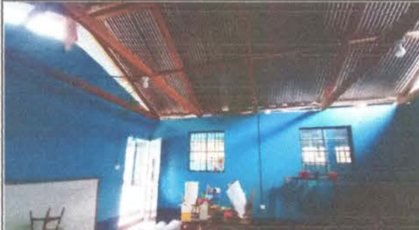
Foto 10: Reparación de sistema eléctrica.
