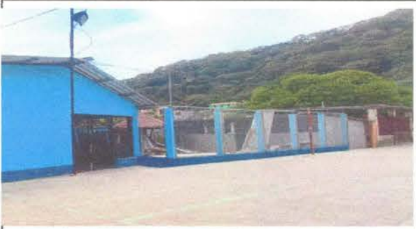
Foto 8: Muros perimetrales (circulación del edificio escolar)
