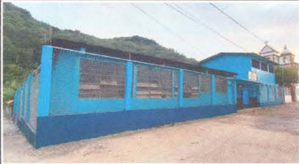
Foto7: Muros perimetrales (circulación del edificio escolar)
