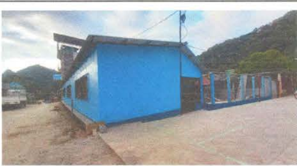
Foto 4: Pintura en muros exteriores e interiores.
