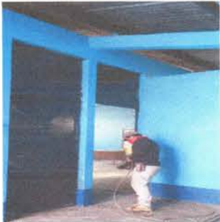
Foto1: Mantenimiento a puertas de metal de aulas.
