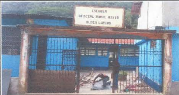
Foto 5: Mantenimientos a portones de metal.
