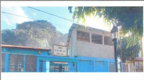
Foto 16: Repellado de paredes de un aula.
