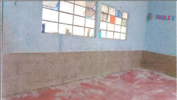
Foto 4: Pintura en muros exteriores e interiores.
