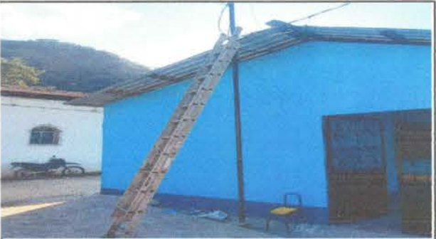
Foto 10: Reparación de sistema eléctrica.
