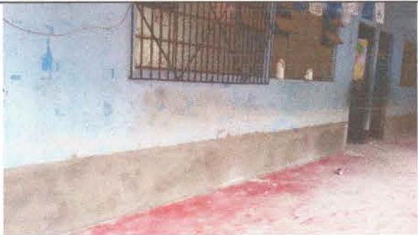
Foto 3: Pintura en muros exteriores e interiores.
