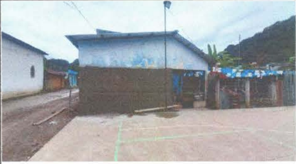
Foto 14: Reparación de repello en paredes.
