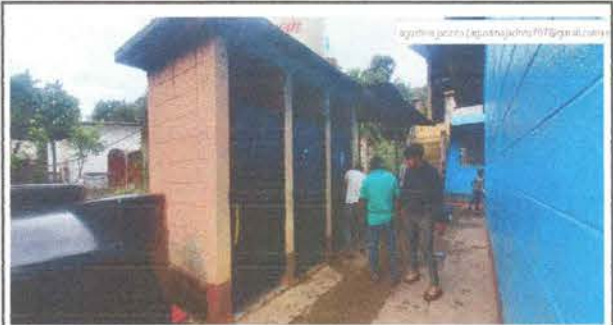
Foto 12: Servicio sanitario en puertas.
