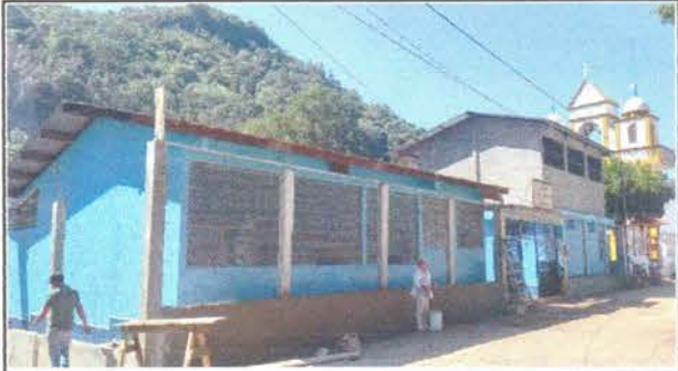
Foto 7: Muros perimetrales (circulación del edificio escolar)
