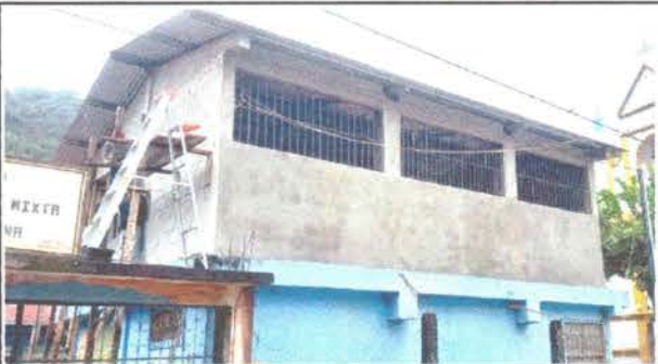
Foto 15: Repellado de paredes de un aula.
