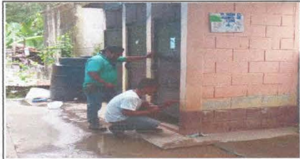
Foto 11: Servicio sanitario en puertas.
