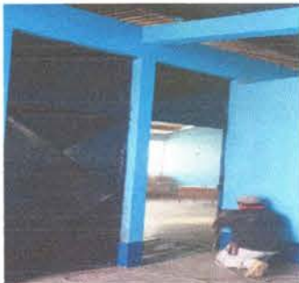
Foto 2: Mantenimiento a puertas de metal de aulas.
