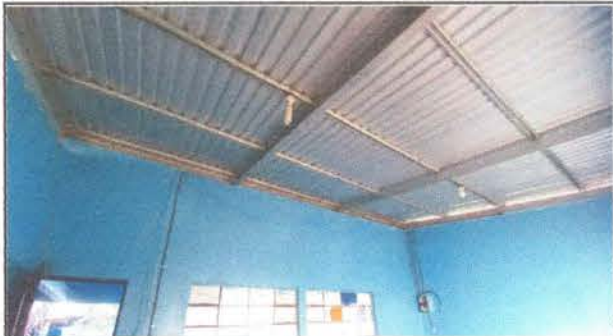
Foto 9: Reparación de sistema eléctrica.
