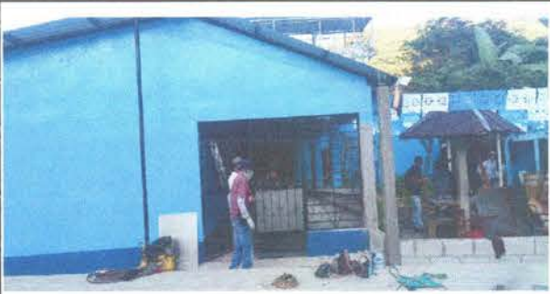
Foto 6: Mantenimientos a portones de metal.
