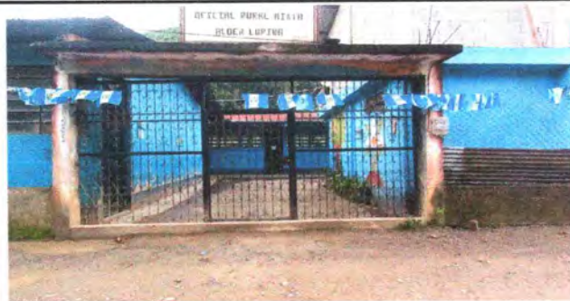
Foto 6: Mantenimiento a portones de metal
