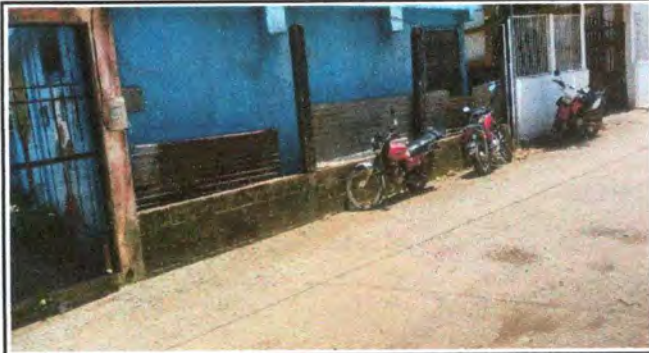
Foto 8: Muros perimetrales (circulación del edificio escolar)
