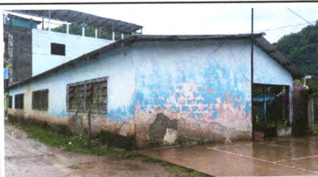
Foto 13: Reparación de repello en paredes.
