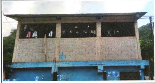
Foto 16: Repellado de paredes de un aula
