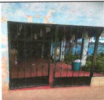
Foto 5: Mantenimiento a portones de metal
