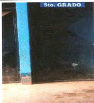
Foto 1: Mantenimiento a puertas de metal de aulas
