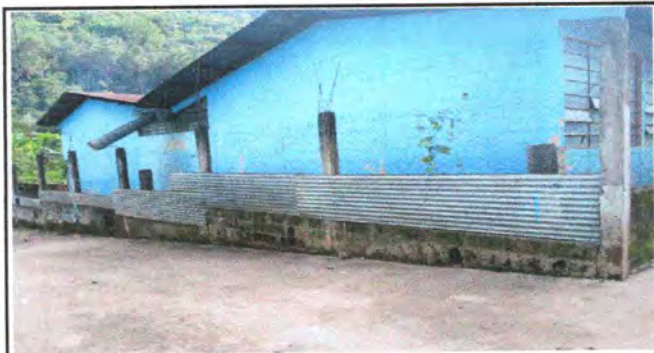
Foto 7: Muros perimetrales (circulación del edificio escolar)
