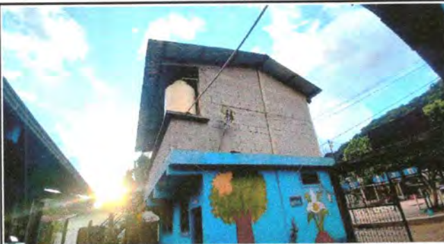
Foto 15: Repellado de paredes de un aula
