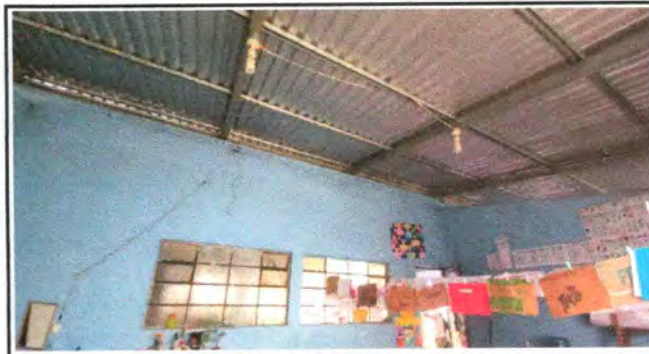
Foto 10: Reparación de sistema eléctrico.
