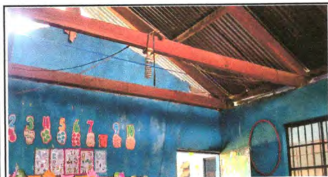
Foto 9: Reparación de sistema eléctrico.
