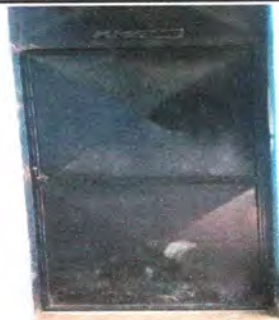
Foto 2: Mantenimiento a puertas de metal de aulas
