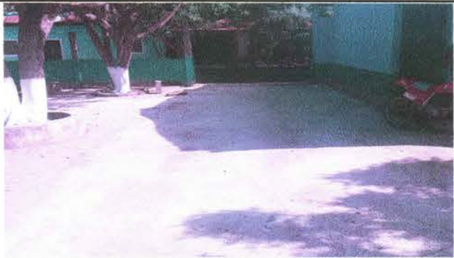
Foto 6: REPARACION DE TORTA DE CONCRETO DE ENTRADA
