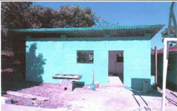
Foto 4: LEVANTAMIENTO DE TECHO Y CAMBIO DE LAMINAS
