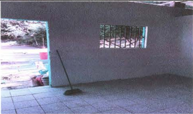
Foto 5: SUSTITUCION DE PISO DE DE TORTA POR GRANITO
