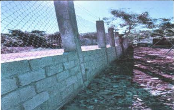
Foto1: CAMBIO DE MALLA POR BASE DE BLOCK Y CEMENTO.
