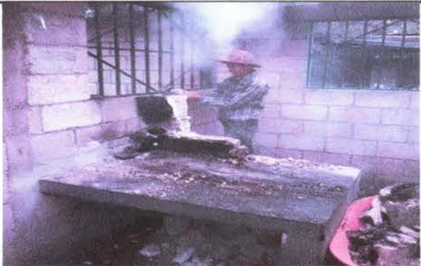
Foto 3: SUSTITUCIÓN DE PLANCHA DE METAL
