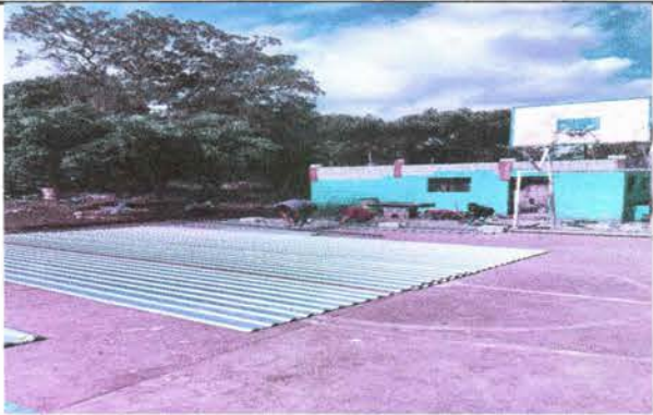
Foto 4: LEVANTAMIENTO DE TECHO Y CAMBIO DE LAMINAS
