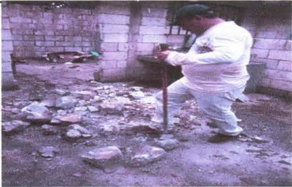
Foto 5: SUSTITUCION DE PISO DE DE TORTA POR GRANITO
