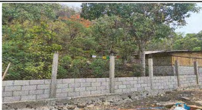
Foto 6: Reparación de muro perimetral con block, malla galvanizada, soleras intermedias y columna de concreto.
