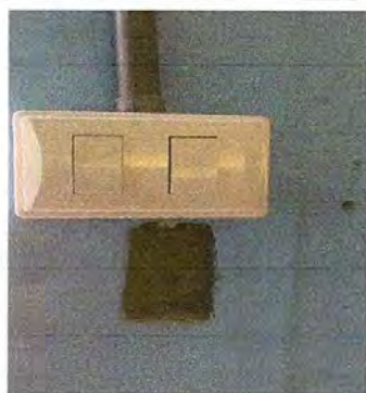
Foto 9: Sustrución de interruptores dobles.
