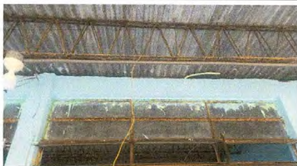
Foto 11: Sustrución de cableado eléctrico
