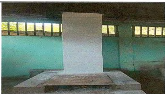
Foto 3: Reparación de chimenea de ladrillo.
