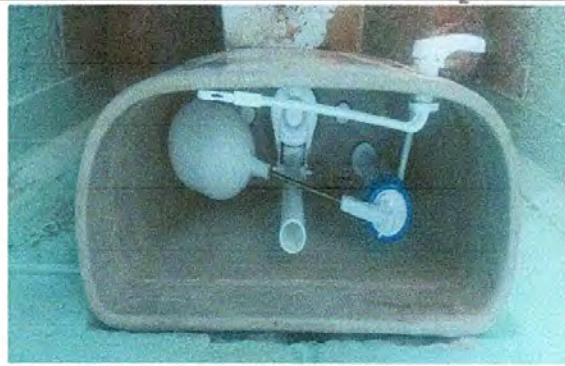
Foto 14: Sustitución de accesorios de inodoro.
