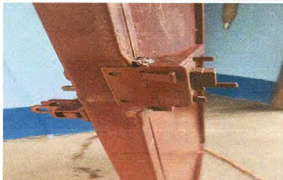
Foto 13: Sustitución de chapa.
