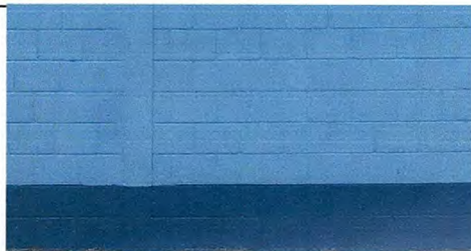
Foto 18: Pintura en muros interiores y exteriores.
