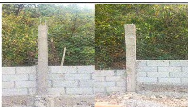
Foto 4: Reparación de muro perimetral con block, malla galvanizada, soleras intermedia y columna de concreto.
