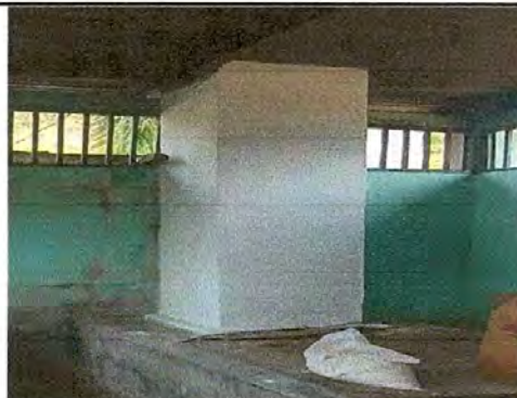
Foto 2: Sustitución de chimenea de concreto.
