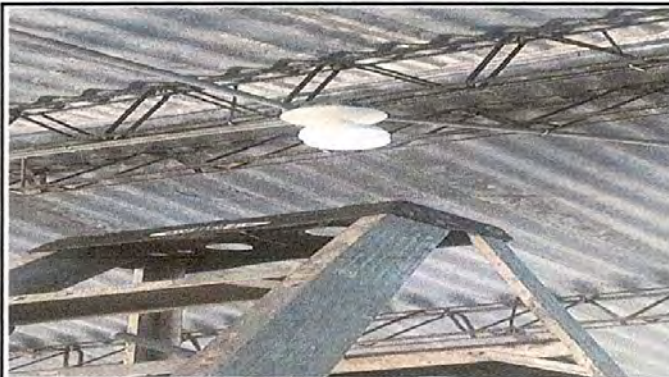
Foto 8: Sustrución de plafoneras.
