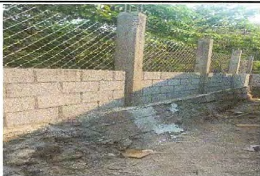
Foto 5: Reparación de muro perimetral con block, malla galvanizada, soleras intermedias y columna de concreto.
