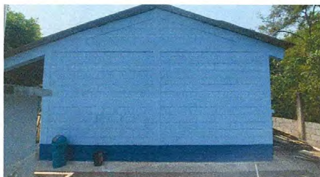
Foto 16: Pintura en muros interiores y exteriores.
