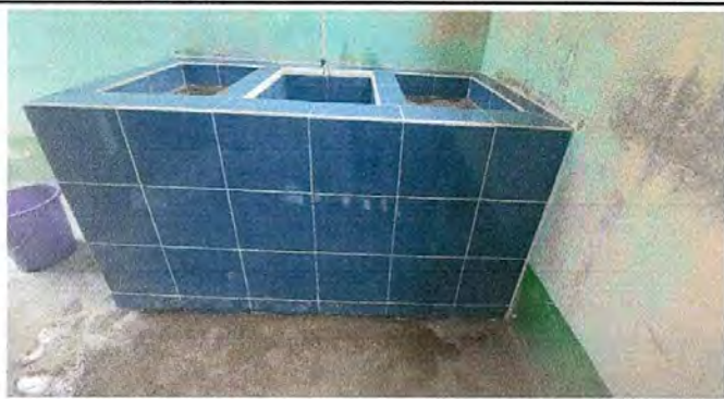
Foto 1: Instalación de azulejo en pila de cementode dos lavaderos.
