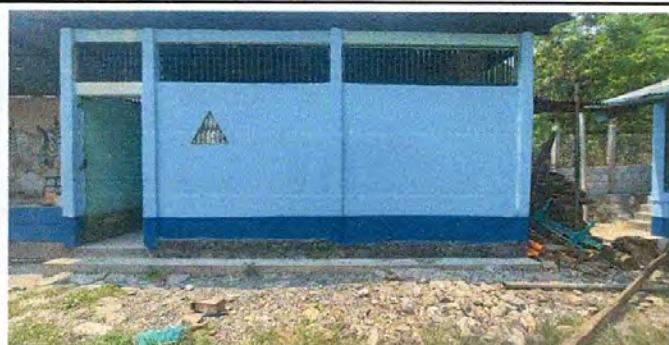
Foto 17: Pintura en muros interiores y exteriores.
