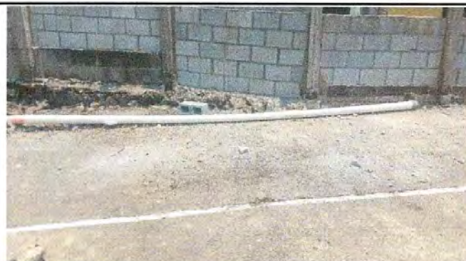
Foto 12: Sustrución de tubería PVC línea principal de aguas negras.
