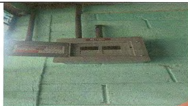
Foto 10: Sustrución de tablero de flipón.
