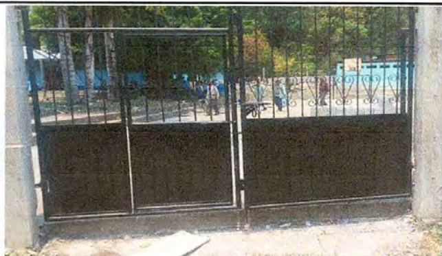
Foto 15: Mantenimiento a portón de metal.
