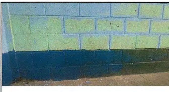
Foto 18: Pintura en muros interiores y exteriores.
