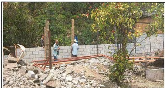
Foto 5: Reparación de muro perimetral con block, malla galvanizada, soleras intermedias y columna de concreto.
