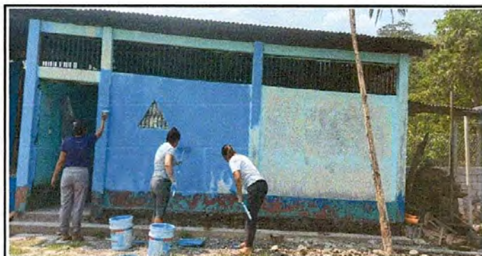
Foto 17: Pintura en muros interiores y exteriores.
