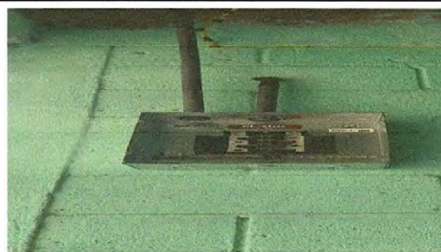
Foto 10: Sustitución de tablero de flipón.
