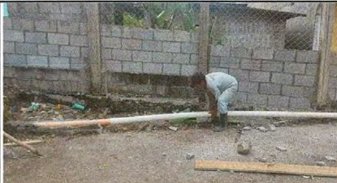
Foto 12: Sustitución de tubería PVC línea principal de aguas negras.
