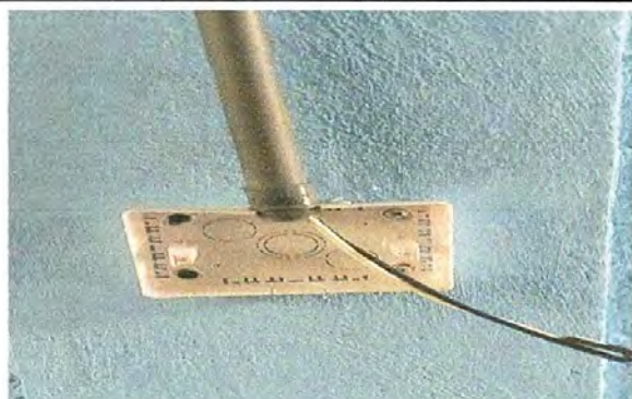
Foto 9: Sustitución de interruptores dobles.
