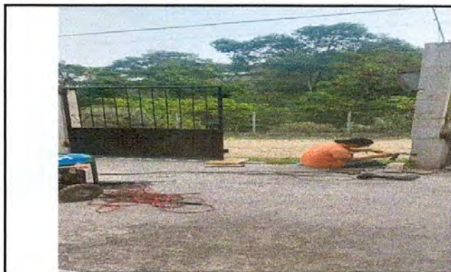
Foto 15: Mantenimiento a portón de metal.
