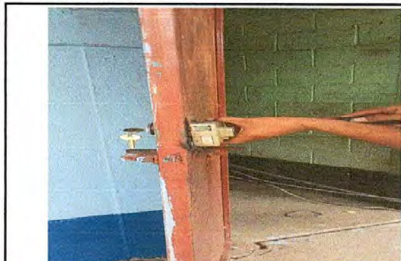
Foto 13: Sustitución de chapa.
