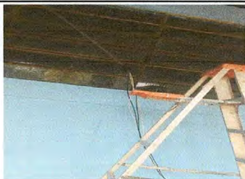
Foto 11: Sustitución de cableado eléctrico
