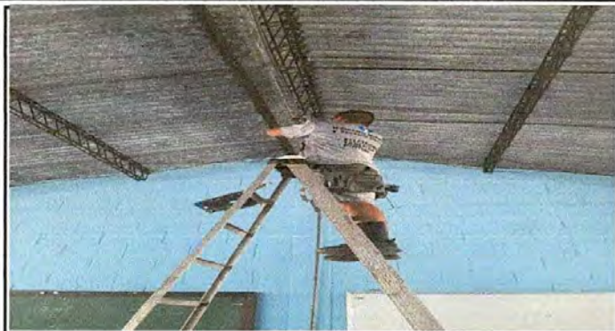
Foto 7: Sustitución de lámparas tipo led.
