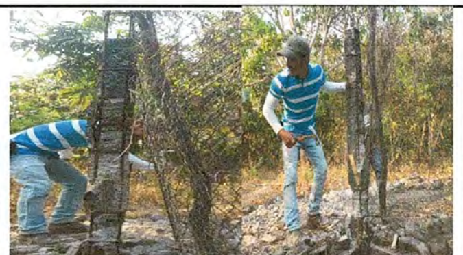
Foto 4: Reparación de muro perimetral con block, malla galvanizada, soleras intermedia y columna de concreto.
