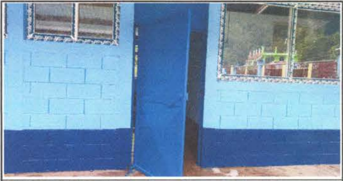
Foto 6: aplicación de pintura
