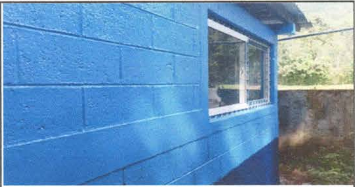
Foto 2: Sustitución de ventana
