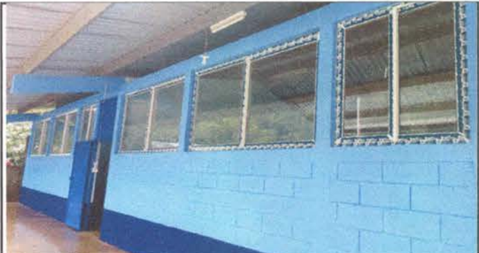
Foto 4: Pintura de muros interiores y exteriores
