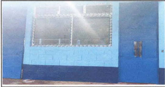
Foto 5: Aplicación de pintura
