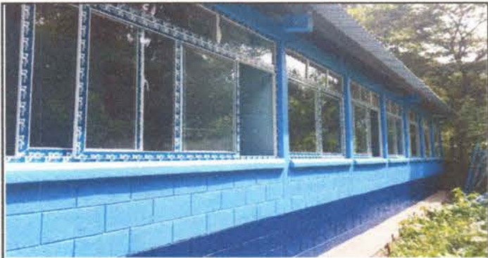
Foto1: Sustitución de ventana
