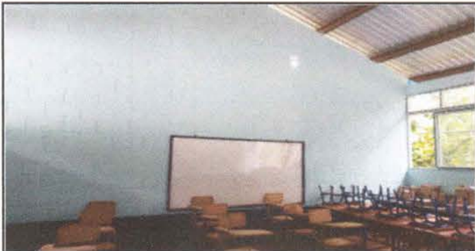
Foto 3: Pintura de muros interiores y exteriores
