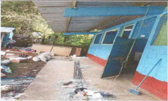
Foto 5: Aplicación de pintura
