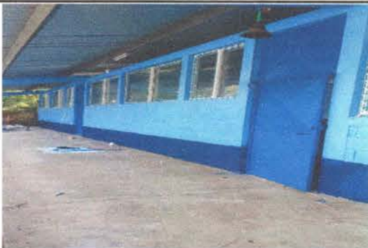
Foto 6: aplicación de pintura
