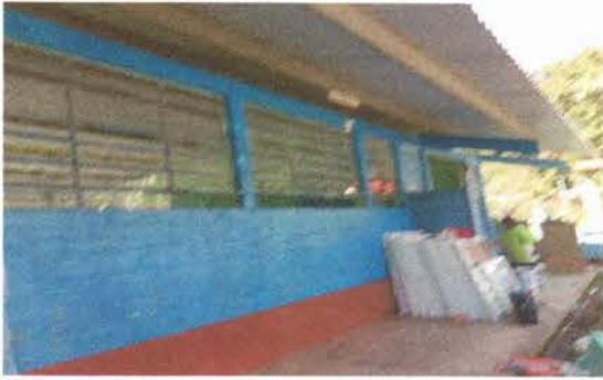
Foto 4: Pintura de muros interiores y exteriores
