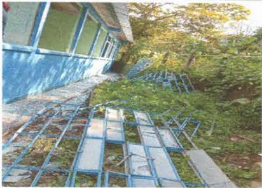
Foto1: Sustrucción de ventana
