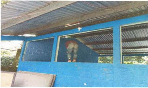
Foto 2: Sustrucción de ventana
