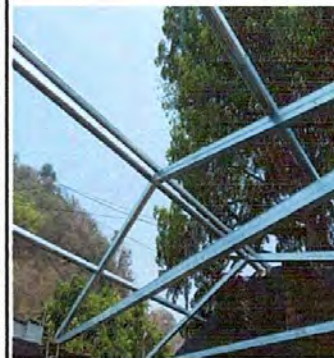
ESTRUCTURA DE TECHO
