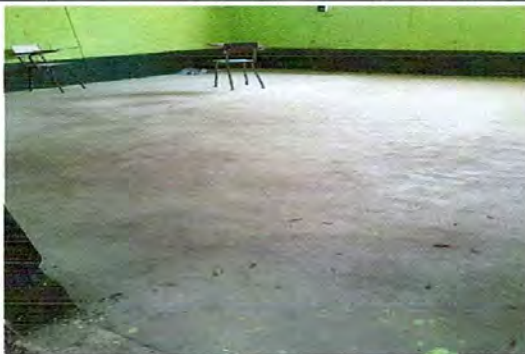
REPARACION DE PISO
