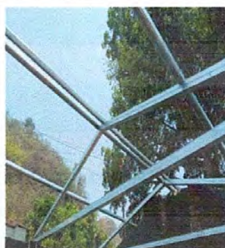
1.2 ESTRUCTURA DE TECHO
