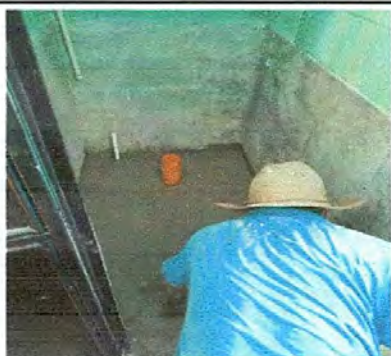
REPARACION DE PISO
