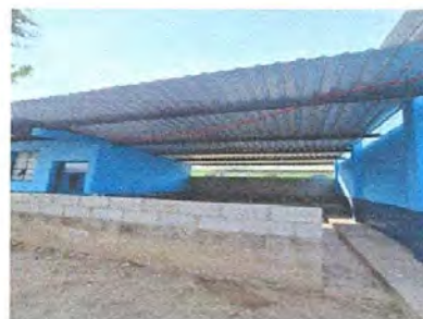
Foto 6: sustitucion de lamina, por lamina troquelada
