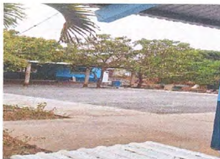
Foto 3: Reparacion de planchas de concreto de patio.
