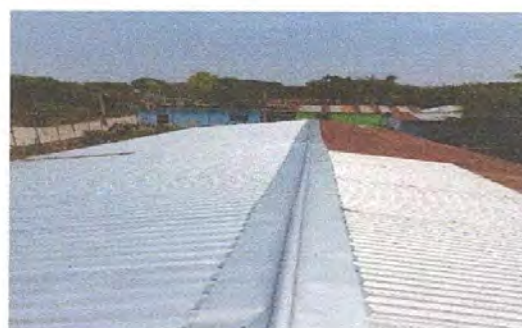
Foto 2: Sustitucion de láminas, por laminas troqueladas.
