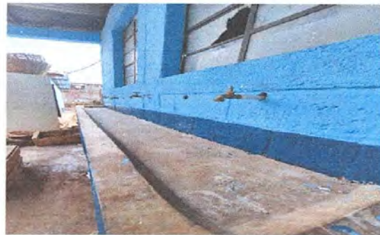
Foto 10: Sustitucion de llave de chorro.
