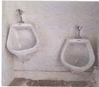
Foto 7: Sustitucion de mingitorios
