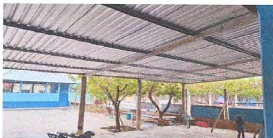
Foto 5: Sustitucion de lamina, por lamina troquelada y sustitucion de estructuta de metal por metal
