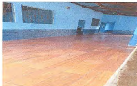
Foto 4: Sustitucion de piso de torta de concreto por piso cerámico
