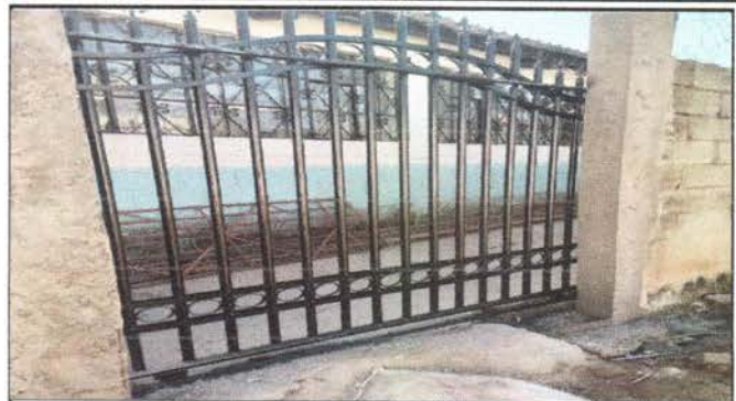
Foto 2: Sustrución de portón de metal entrada lateral
