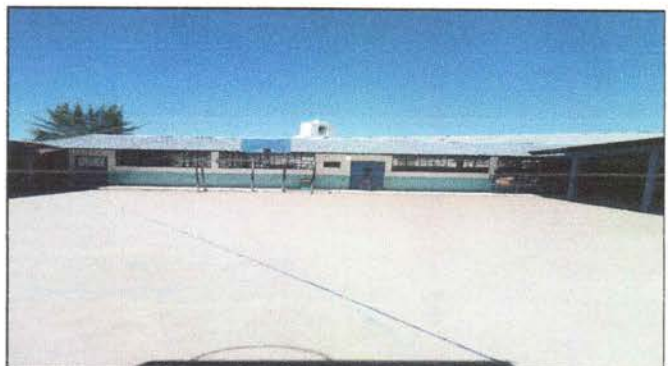
Foto 4: Sustrución de cubierta de lámina
