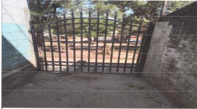
Foto1: Sustrución de portón de metal entrada principal
