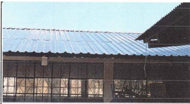
Foto 5: Sustrución de cubierta de lámina
