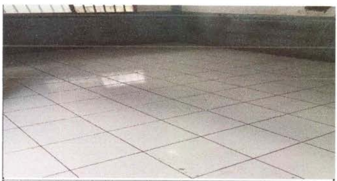
Foto 6: Sustrución de piso por piso cerámico
