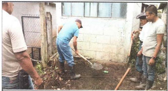
Foto 2: Padres de familia trabajando para la remodelacion del muro perimetral
