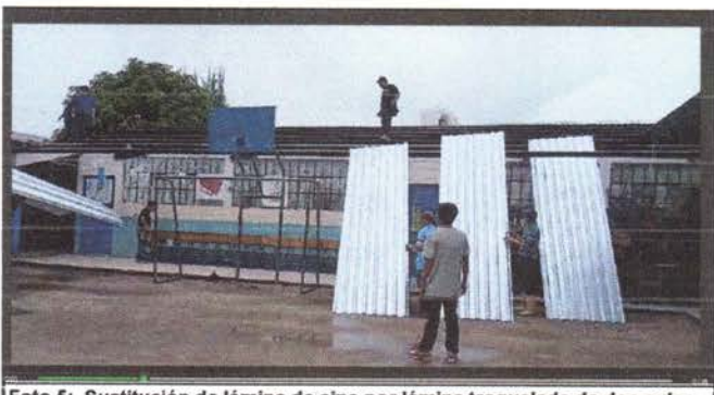
Foto 5: Sustitución de lámina de cinc por lámina troquelada de dos aulas
