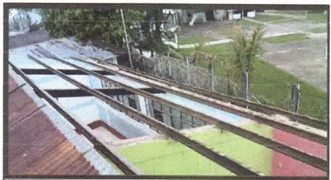
Foto 4: Sustitución de techo de lámina de zinc por lámina troquelada de dos aulas
