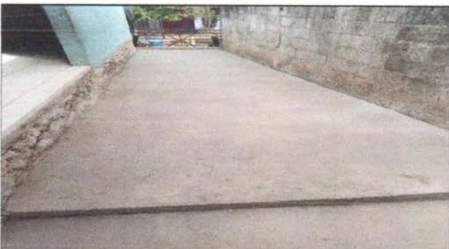
Foto 9: Avance de la sustitución del piso de concreto
