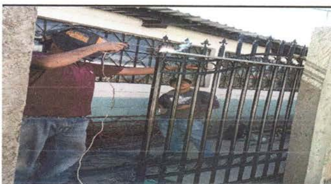
Foto 10: Colocación de uno de los portones de metal
