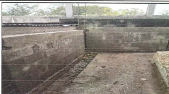
Foto 8: Avance de remodelación del muro perimetral
