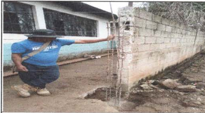
Foto 3: Sustitución de uno de los portones, entrada lateral
