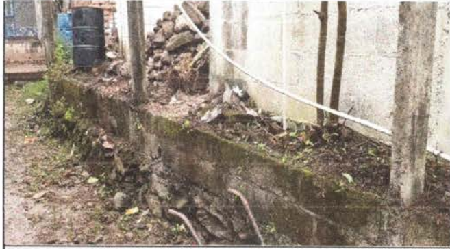
FOTO 1: INICIO DE LA REMODELACION DEL MURO PERIMETRAL
