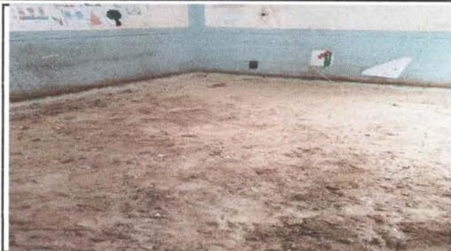
Foto 7: Inicio del trabajo de sustitución de piso de granito por piso cerámico
