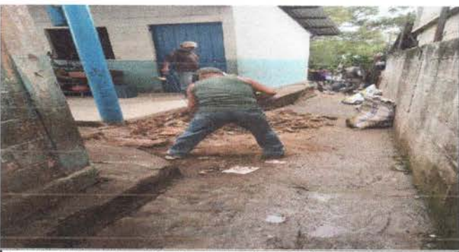
Foto 11: Inicio de la sustitución del piso de concreto
