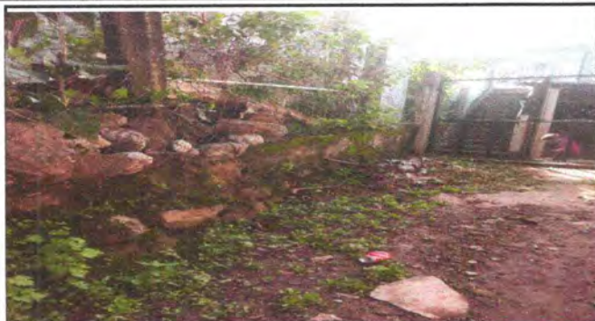
Reparación de muro perimetral de block
