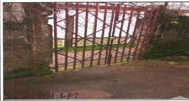
Sustitución de portón de metal
