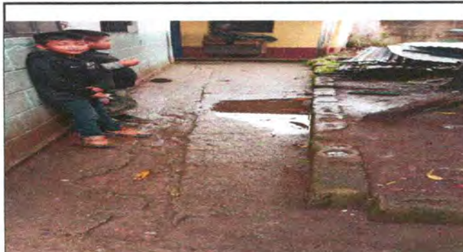
Reparación de piso de torta de concreto
