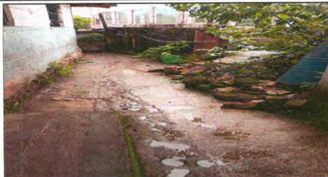
Reparación de piso de torta de concreto
