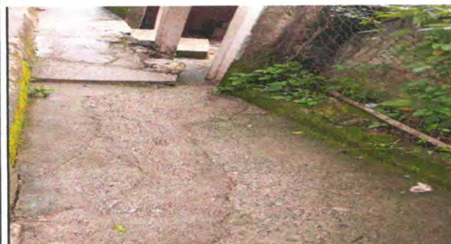
Reparación de piso de torta de concreto
