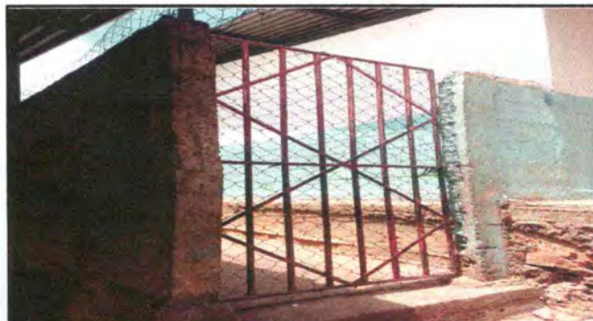
Sustitución de portón de metal
