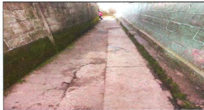
Reparación de piso de torta de concreto
