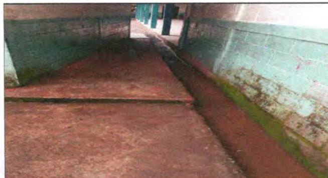
Reparación de piso de torta de concreto
