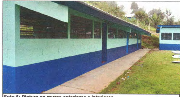
Foto 5: Pintura en muros exteriores e interiores
