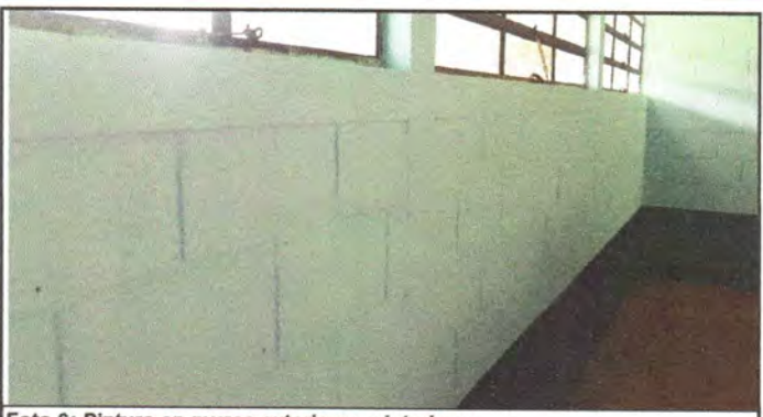
Foto 6: Pintura en muros exteriores e interiores
