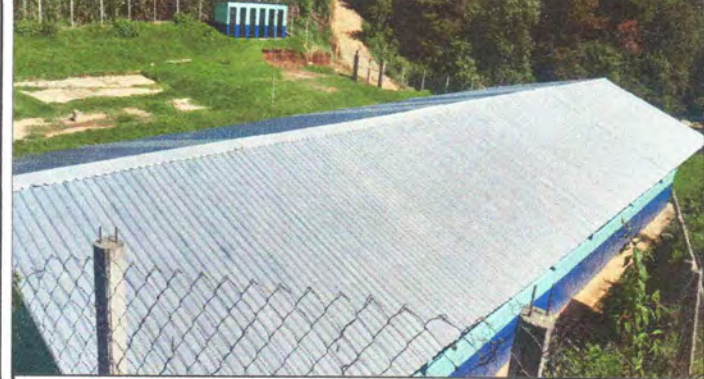
Foto1: Sustitución de lámina
