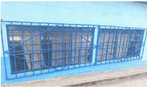
Foto 15: mejoramiento de Balcones y pintura en exteriores
