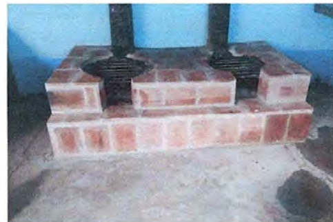
Foto 6: Mantenimiento de Estufa rural
