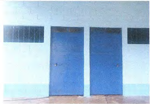
Foto 8: Mantenimiento de 2 puertas de metal
