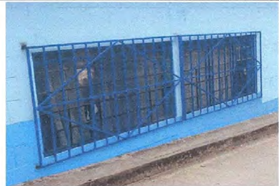
Foto 14: Sustitución de vidrios en ventanas
