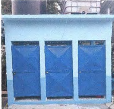
Foto7: Mantenimiento de 3 puertas de metal de baños
