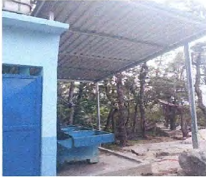
Foto 1: Sustrucción de lamina y estructura de soporte de madera por metal del area de mingitorio
