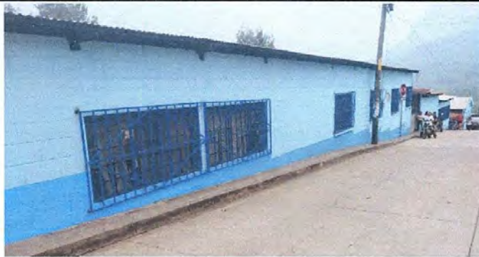
Foto 17: Pintura en exteriores
