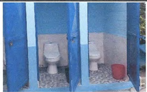
Foto 12: Cambio de accesorios y tapa de taza
