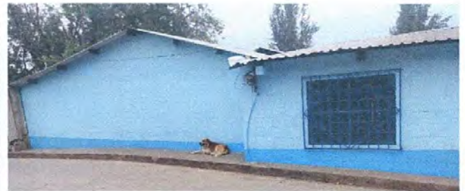
Foto 16: Pintura en exteriores
