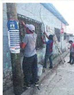
Foto 14: Mejoramiento de Balcones y Cambio de vidrios
