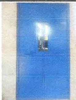
Foto 11: Sustitución de una puerta de madera por metal
