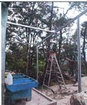
Foto 1: Sustrucción de lamina y estructura de soporte de madera por metal del area de mingitorio
