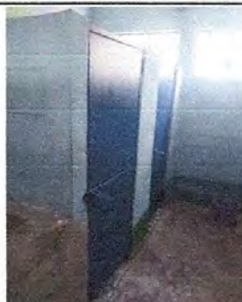
Foto 10: Sustitución de 2 puertas de madera por metal
