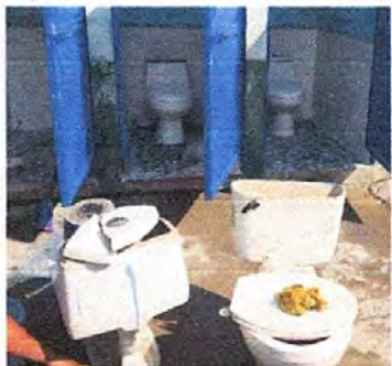
Foto16: Mejoramiento de Baños con azulejos, cambio de accesorios y sustitución de taza.
