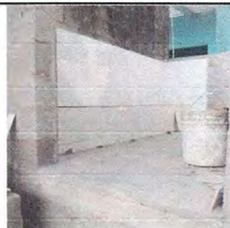
Foto 18: Mejoramiento de Mingitorio y reparación de pared
