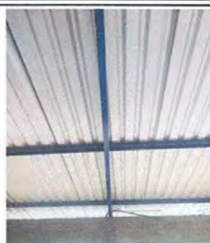
Foto 2: Sustrucción de lamina y estructura de soporte de madera por metal del area de cocina
