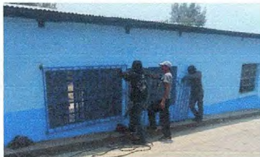
Foto 15: mejoramiento de Balcones y cambio de vidrios
