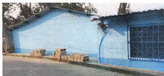
Foto 16: Pintura en exteriores
