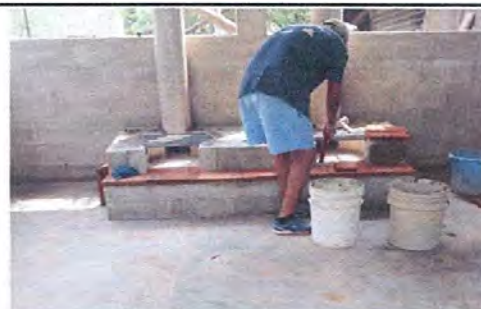
Foto 6: Mantenimiento de Estufa rural y sustrucción de una más
