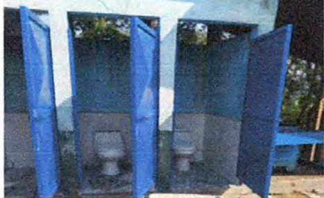
Foto 7: Mantenimiento de 3 puertas de metal de baños
