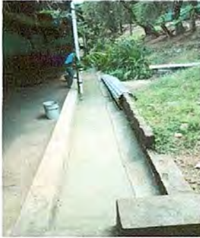
Foto 1: MANTENIMIENTO Y REPARACIÓN DE CUNETA DE CONCRETO
