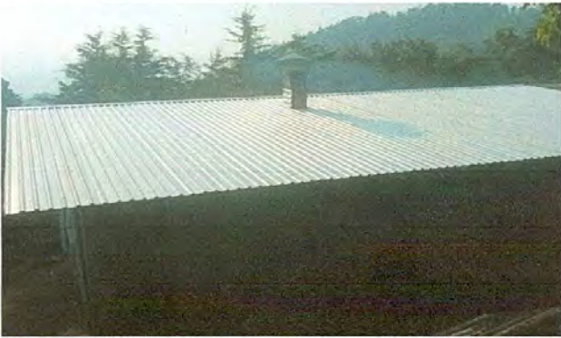
Foto 1: SUTITUCIÓN DE LÁMINAS POR LÁMINAS TROQUELADAS DE CALIBRE 26 , CAPOTES Y TORTILLOS
