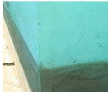
Foto 6: MANTENIMIENTO Y REPARACIÓN DE PARED
