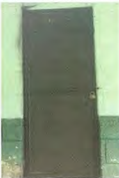
Foto 5: MANTENIMIENTO DE PUERTAS DE BAÑOS
