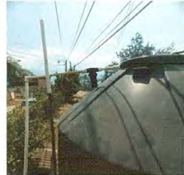
Foto 2: CAMBIO DE VÁLVULA
