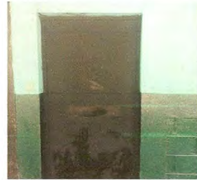
Foto 2: MANTENIMIENTO DE PUERTAS
