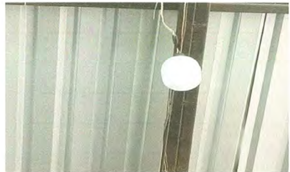
Foto 4: SUSTITUCIÓN DE CABLES, PLAFONERAS Y FOCOS
