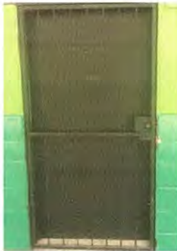
Foto 3: MANTENIMIENTO DE PUERTAS DEL ÁREA DE COMPUTACIÓN
