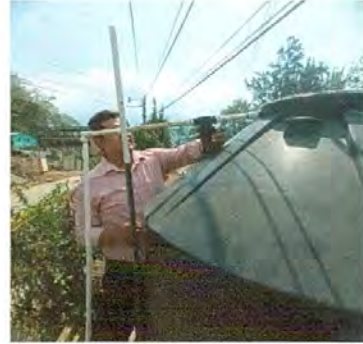
Foto 2: CAMBIO DE VÁLVULAS
