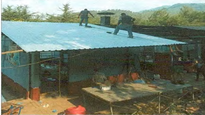
Foto1: SUSTITUCIÓN DE LÁMINAS POR LÁMINAS TROQUELADAS CALIBRE 26, CAPOTES Y TORTILLOS
