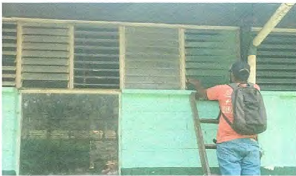
Foto 3: SUSTITUCIÓN DE VIDRIOS
