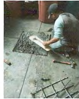
Foto 4: MANTENIMIENTO DE DRENAJE
