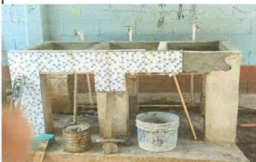
Foto 5: MANTENIMIENTO Y REPARACIÓN DE PILA
