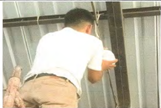
Foto 4: SUSTITUCIÓN DE CABLES, PLAFONERAS Y FOCOS
