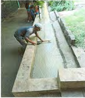
Foto1: MANTENIMIENTO DE CUNETA DE CONCRETO
