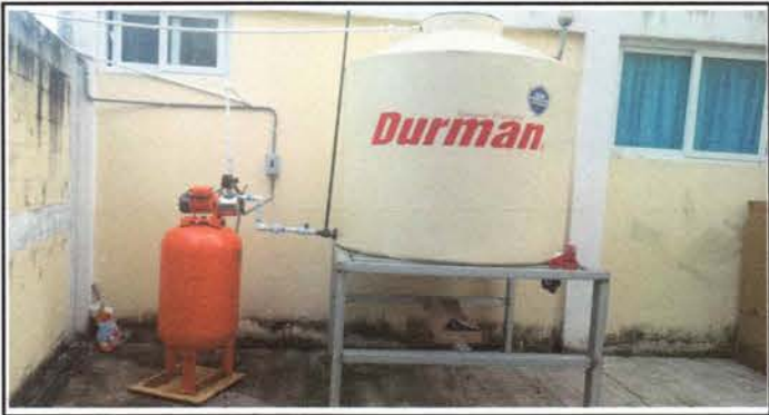
Foto 12: Sustitución de depósito de agua
