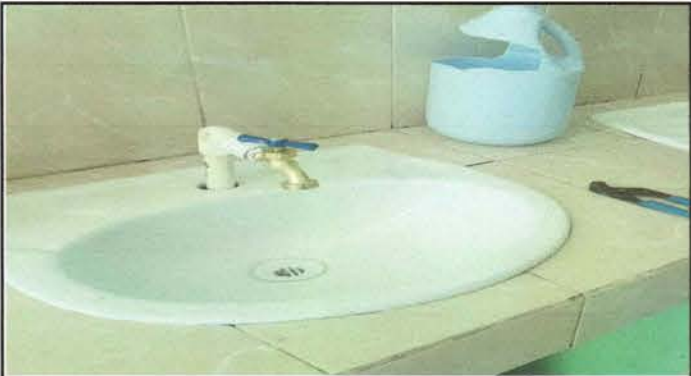
Foto 10: Sustitución de llave de chorro
