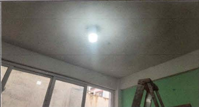
Foto 7: Sustitución de focos ahorradores
