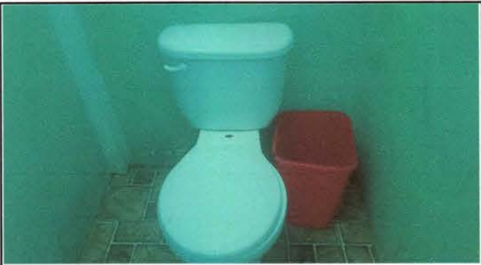
Foto 2: Sustitución de accesorio de inodoros.
