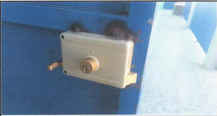
Foto 11: Sustitución de chapa
