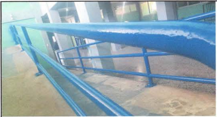
Foto 3: Mantenimiento de barandas
