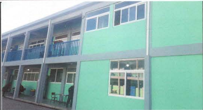
Foto1: Aplicación de pintura en partes deterioradas.
