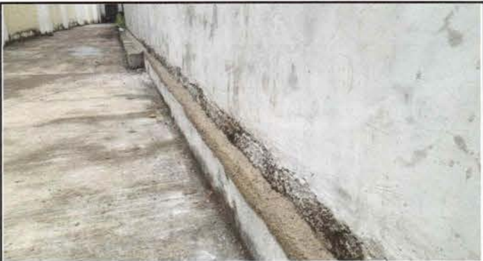
Foto 9: Sustitución de tubería lineal principal
