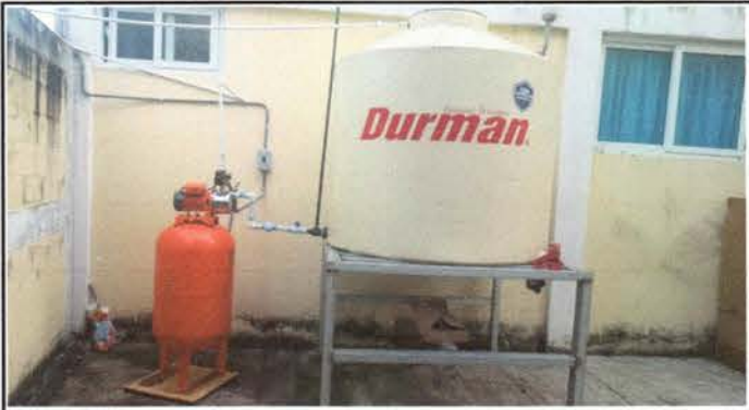
Foto 4: Sustitución de bomba de agua
