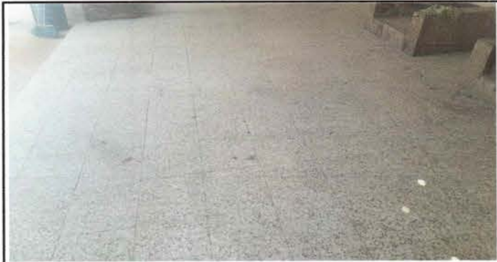
Foto 5: Sustitución de piso de torta de concreto por piso de granito en cocina
