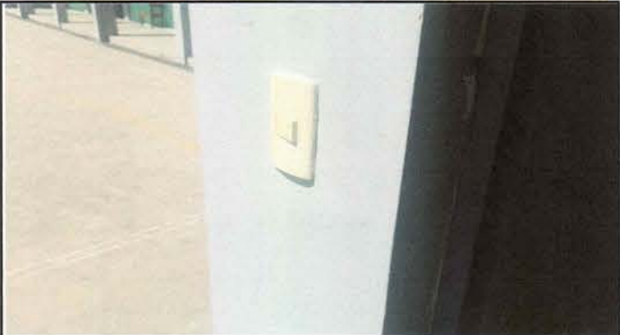
Foto 8: Sustitución de interruptores simples.
