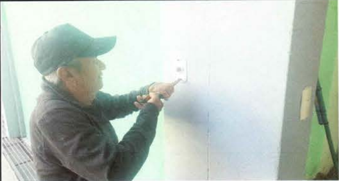
Foto 8: Sustitución de interruptores simples.
