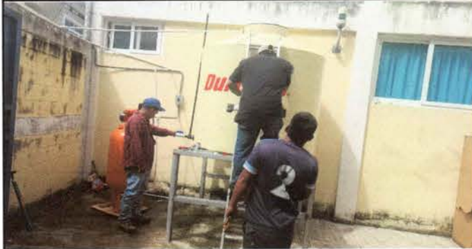
Foto 12: Sustitución de depósito de agua
