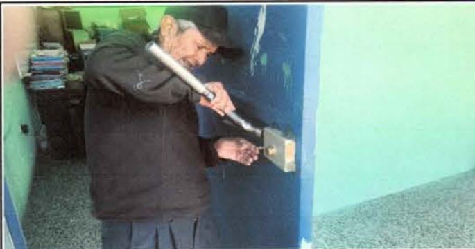
Foto 11: Sustitución de chapa
