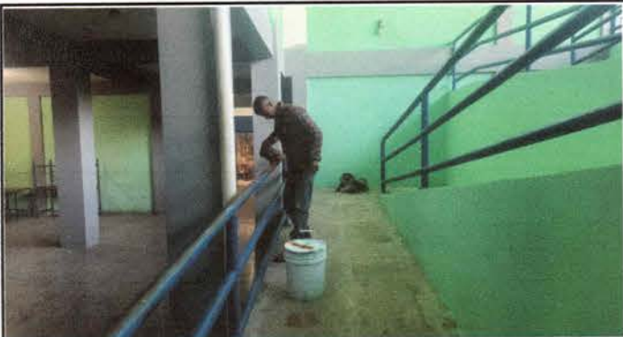
Foto 3: Mantenimiento de barandas
