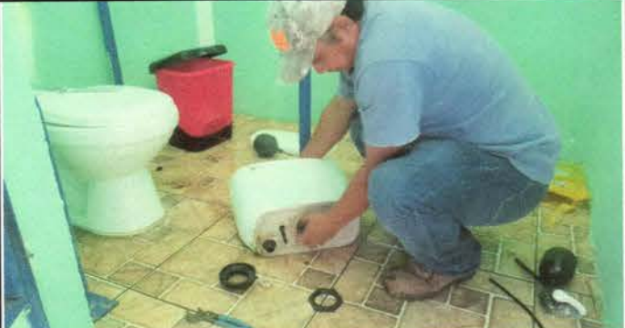
Foto 2: Sustitución de accesorio de inodoros.
