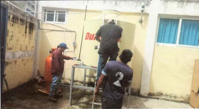
Foto 4: Sustitución de bomba de agua
