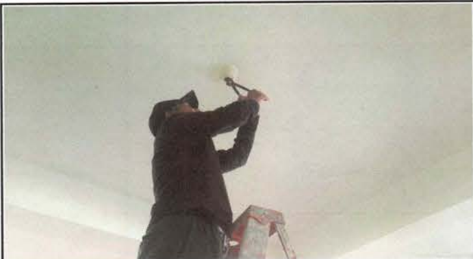
Foto 7: Sustitución de focos ahorradores
