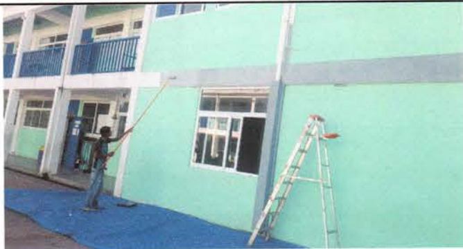
Foto1: Aplicación de pintura en partes deterioradas.
