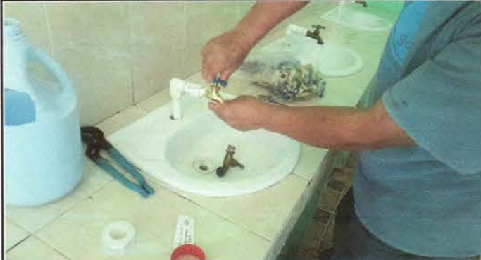
Foto 10: Sustitución de llave de chorro
