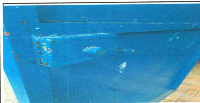
Foto 11: Sustitución de chapa
