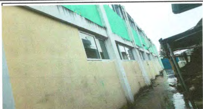
Foto1: Aplicación de pintura en partes deterioradas.
