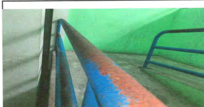
Foto 6: Mantenimiento a barandas de metal
