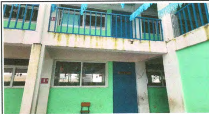
Foto 4: Aplicación de pintura en columnas deterioradas
