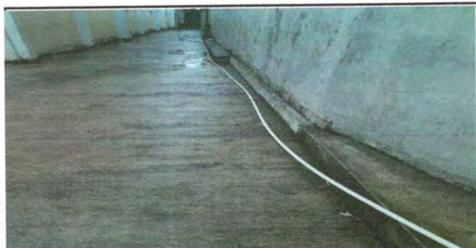
Foto 9: Sustitución de tubería lineal principal
