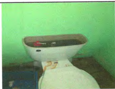
Foto 5: Sustitución de accesorios de inodoros
