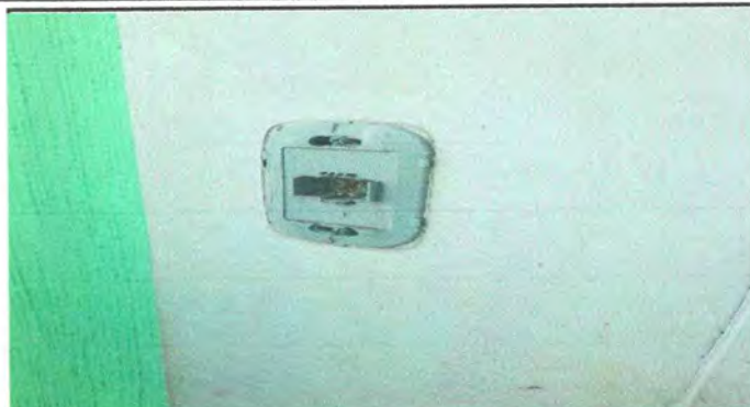
Foto 8: Sustitución de interruptores simples.
