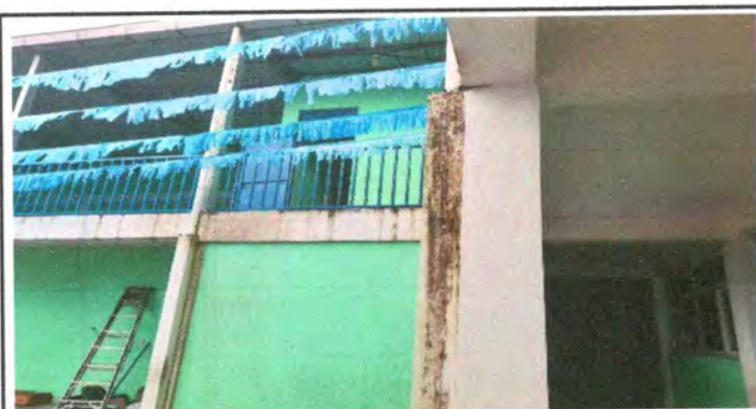
Foto 3: Aplicación de pintura en columnas deterioradas
