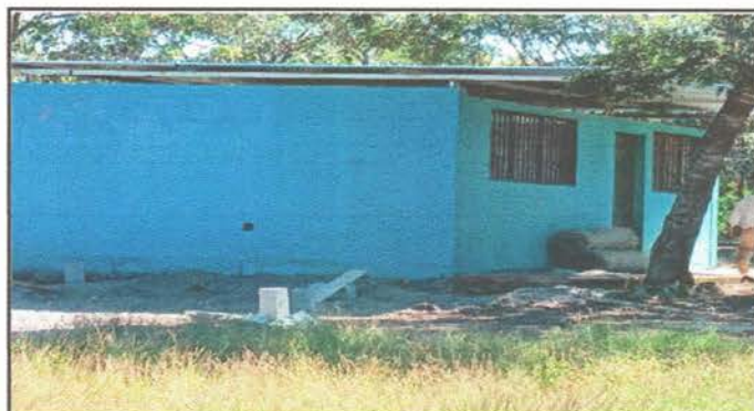
Foto 4: Sustitución de lámina
