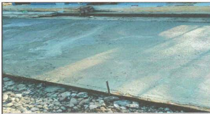
Foto 17: Reparación de planchas de concreto de patio
