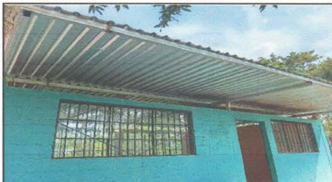
Foto 3: Sustitución de lámina
