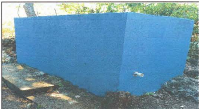
Foto 15: Reparación de sisterna de concreto
