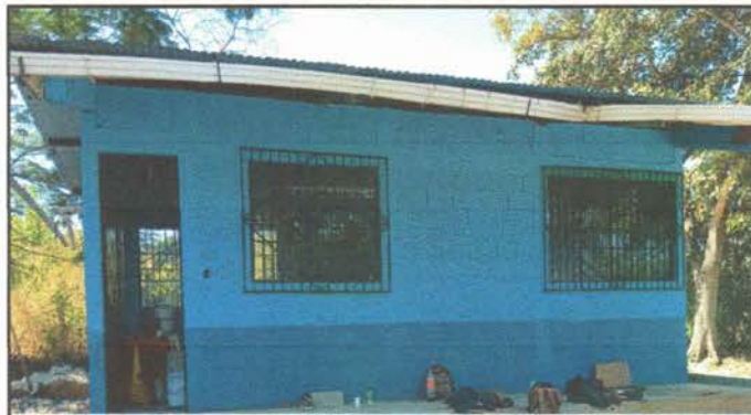
Foto 8: Pintura de muros
