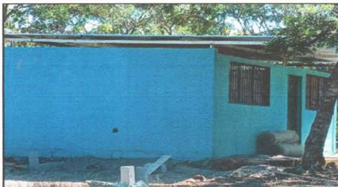
Foto 9: Levantamiento de aula
