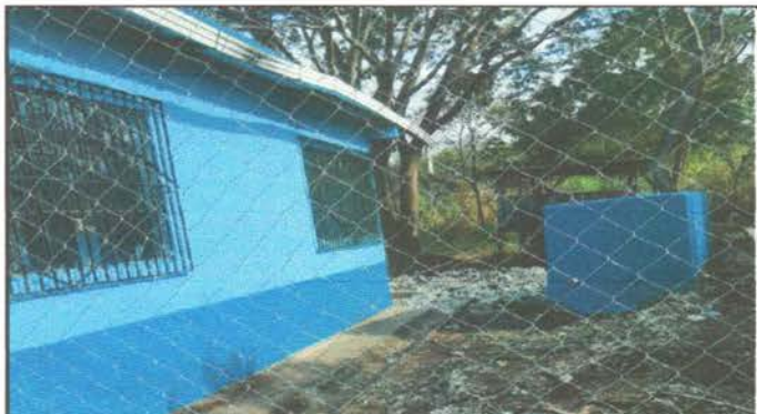
Foto 16: Reparación de sisterna de concreto
