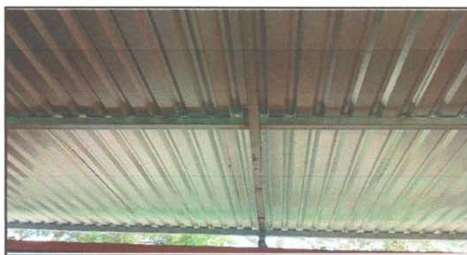
Foto 6: Sustitución de estructura de madera por metal
