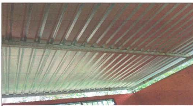
Foto 5: Sustitución de estructura de madera por metal
