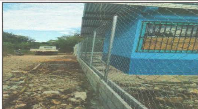
Foto 2: Reparación de muro perimetral
