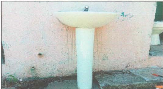
Foto 14: Sustrucción de lavamanos
