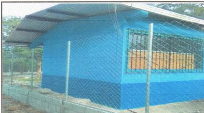
Foto 7: Pintura de muros
