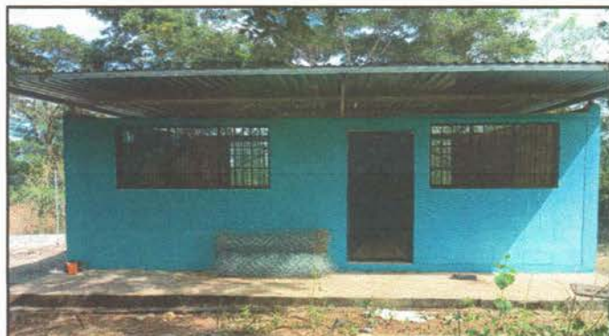
Foto 10: Levantamiento de aula
