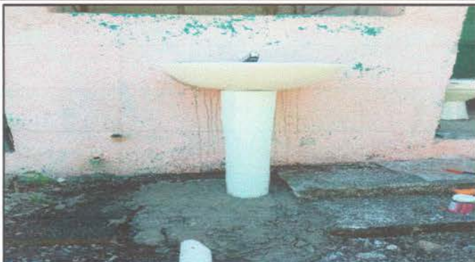
Foto 13: Sustrucción de lavamanos
