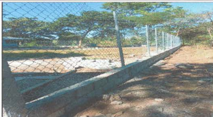
Foto 1: Reparación de muro perimetral
