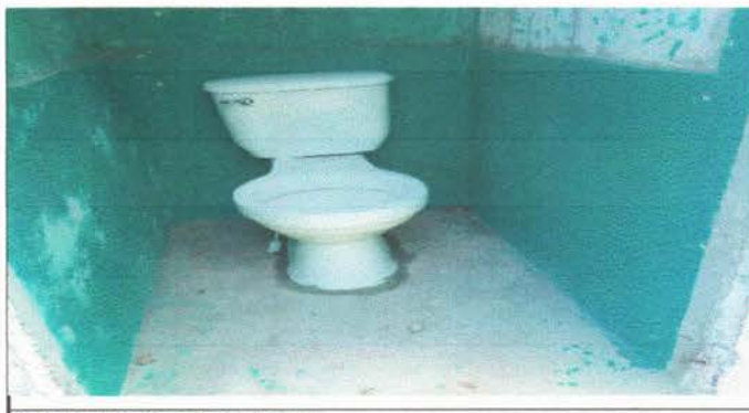
Foto 11: Sustitución de inodoro
