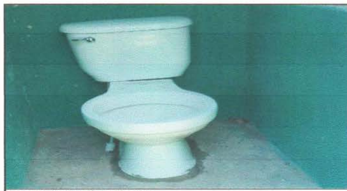
Foto 12: Sustitución de inodoro
