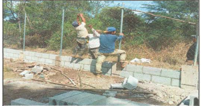
Foto 2: Reparación de muro perimetral
