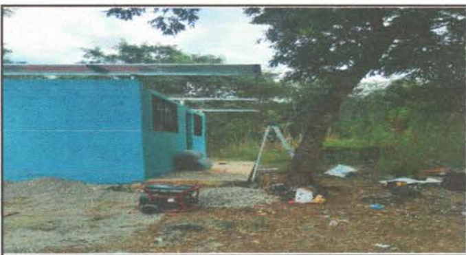
Foto 5: Sustitución de estructura de madera por metal
