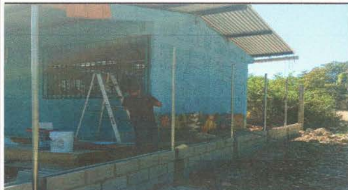
Foto 7: Pintura de muros
