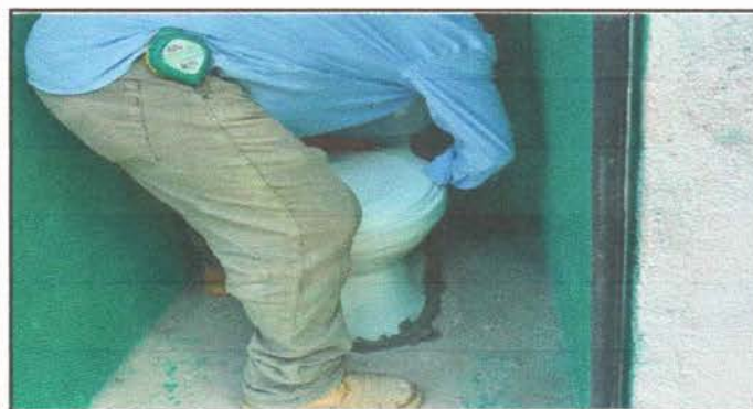
Foto 11: Sustitución de inodoro
