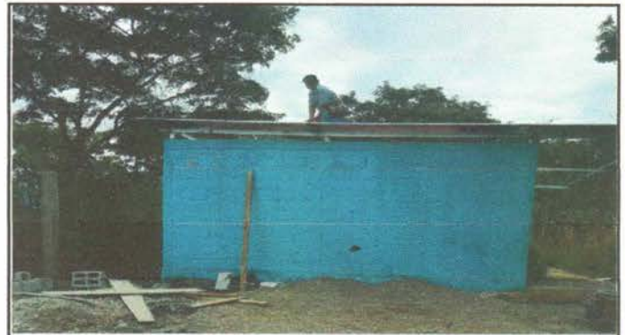
Foto 4: Sustitución de lámina
