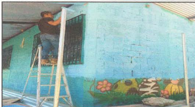
Foto 8: Pintura de muros
