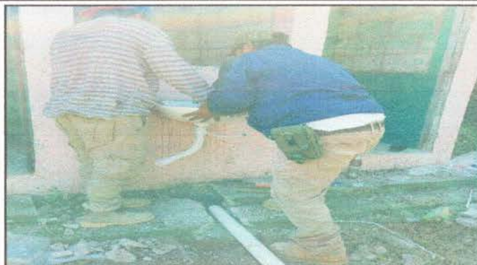
Foto 13: Sustitución de lavamanos
