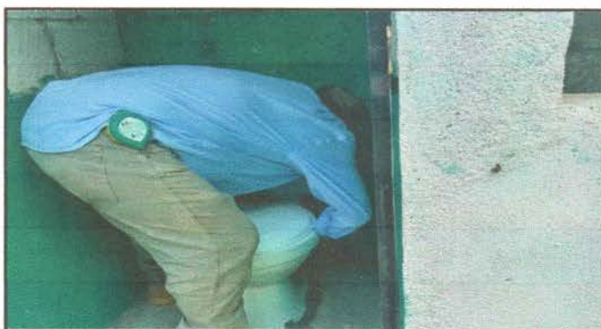
Foto 12: Sustitución de inodoro
