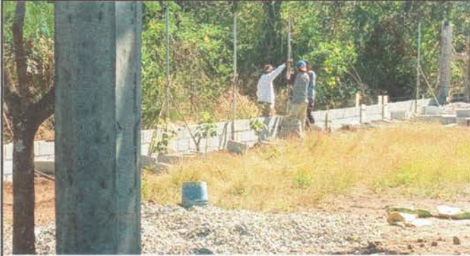
Foto1: Reparación de muro perimetral
