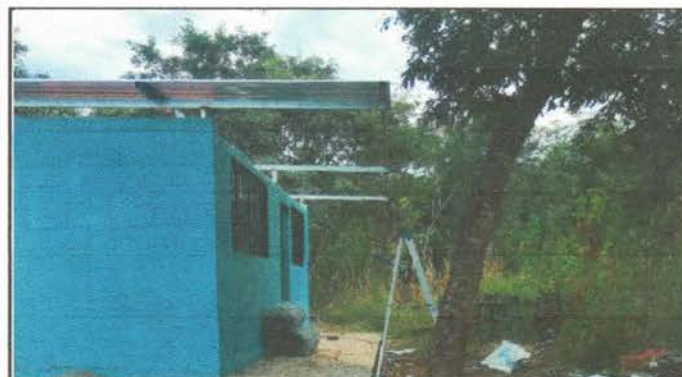
Foto 9: Levantamiento de aula
