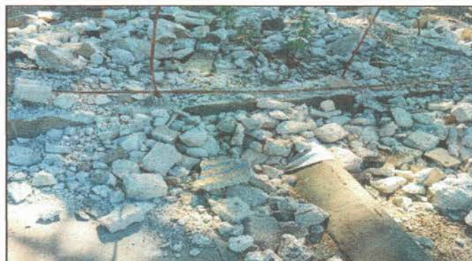
Foto 16: Reparación de sisterna de concreto
