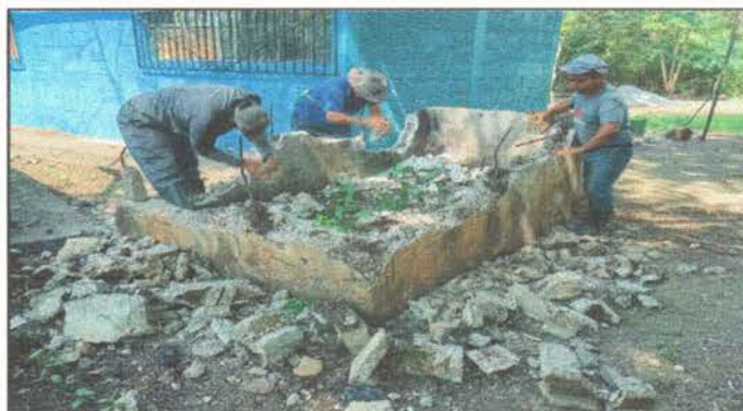
Foto 15: Reparación de sisterna de concreto
