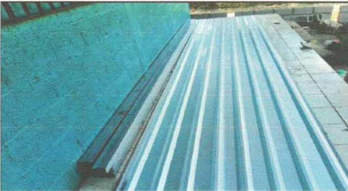
Foto 3: Sustitución de lámina
