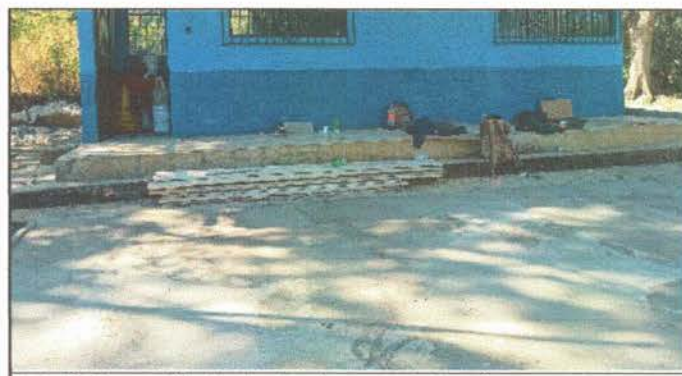
Foto 18: Reparación de planchas de concreto de patio
