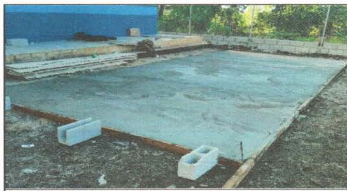
Foto 17: Reparación de planchas de concreto de patio
