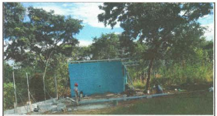
Foto 6: Sustitución de estructura de madera por metal
