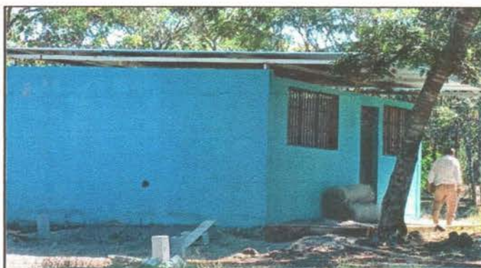
Foto 10: Levantamiento de aula
