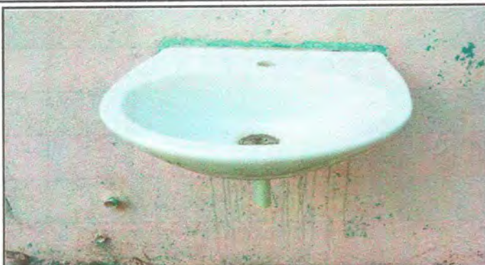
Foto 13: Sustitución de lavamanos
