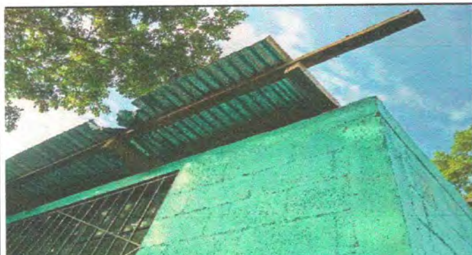
Foto 3: Sustitución de lámina
