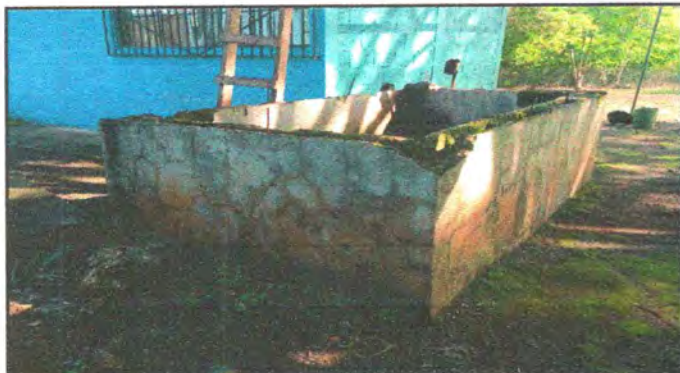
Foto 15: Reparación de sisterna de concreto
