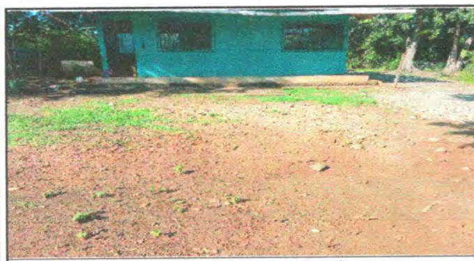
Foto 17: Reparación de planchas de concreto de patio
