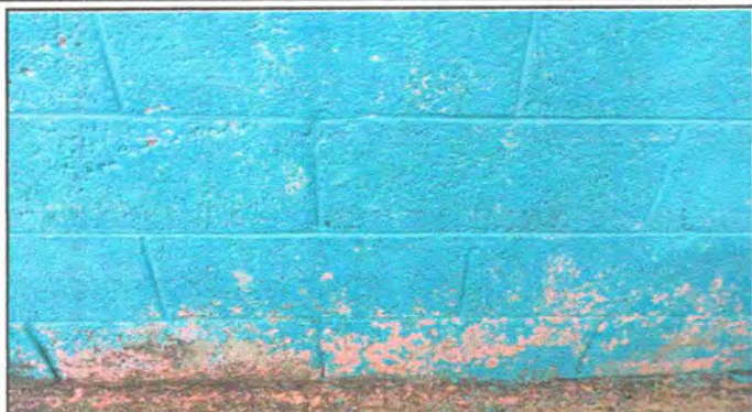
Foto 7: Pintura de muros
