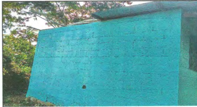
Foto 4: Sustitución de lámina
