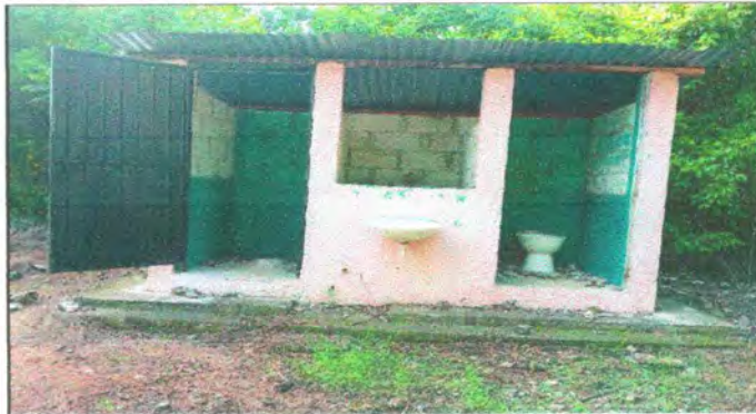
Foto 14: Sustitución de lavamanos
