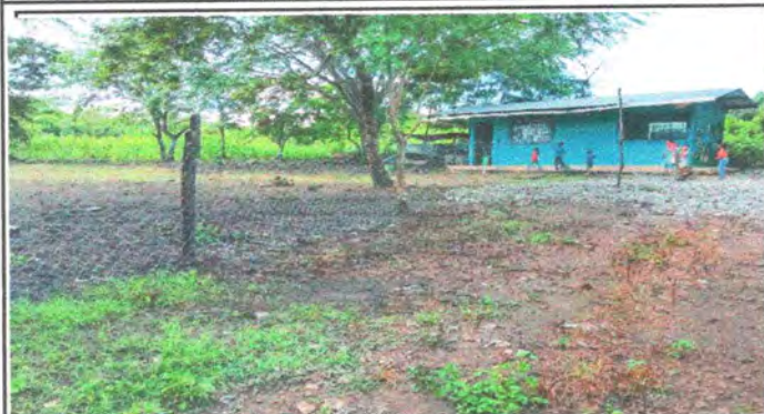
Foto 1: Reparación de muro perimetral
