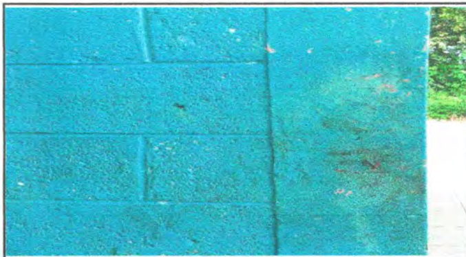
Foto 8: Pintura de muros
