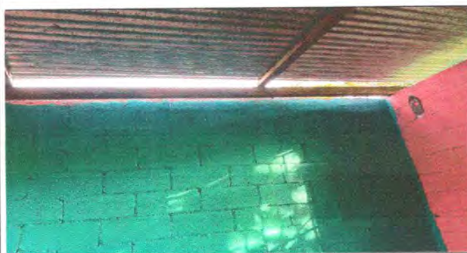
Foto 5: Sustitución de estructura de madera por metal
