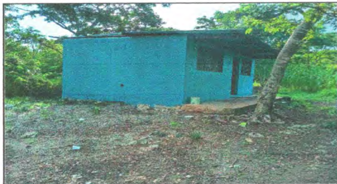
Foto 9: Levantamiento de aula
