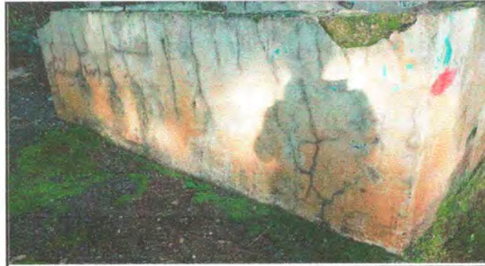
Foto 16: Reparación de sisterna de concreto
