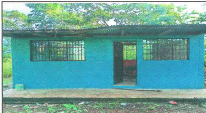
Foto 10: Levantamiento de aula
