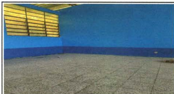
Foto 4: Sustrucción de piso de granito
