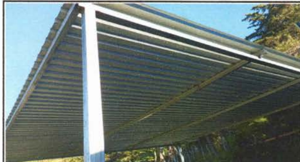
Foto 2: Sustrucción de soporte de estructura de madera por metal
