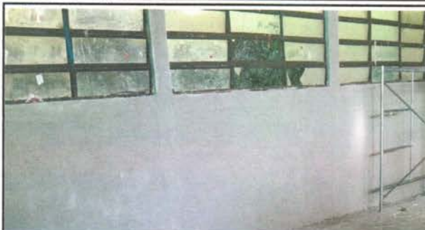
Foto: 8 Repello en muros exteriores e interiores
