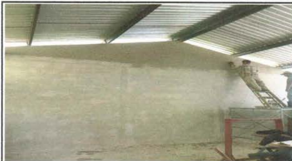
Foto 8 Repello en muros exteriores e interiores
