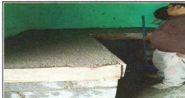
Foto 6: Sustitución de mesa de madera por mesa de concreto, forrado de azulejos
