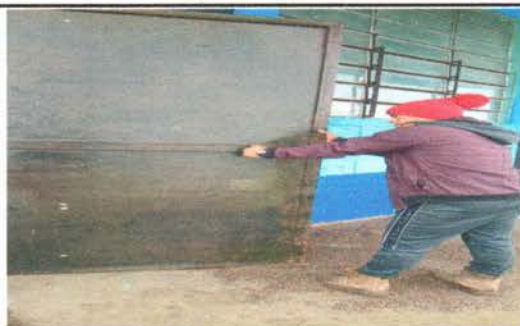
Foto 3: Sustitución de puertas de metal
