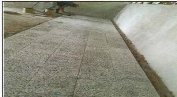
Foto 4: Sustitución de piso de granito
