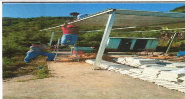
Foto1: Sustitución de lámina por lámina troquelada
