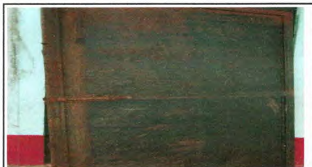
Foto 3: Sustrucción de puertas de metal
