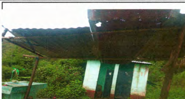
Foto 1: Sustrucción de lámina por lámina troquelada
