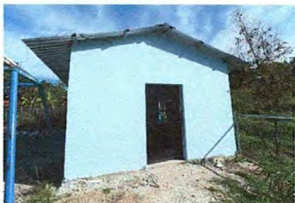
Foto1 1: Cubierta y estructura de soporte instalada y terminada
