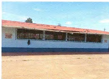
Foto 3: Aplicación de pintura terminada
