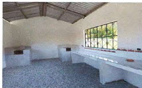
Foto 6: Estufas rurales instaladas y terminadas
