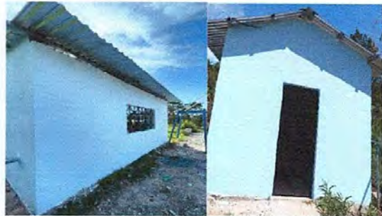
Foto 8: Mejoramiento pared cocina terminado
