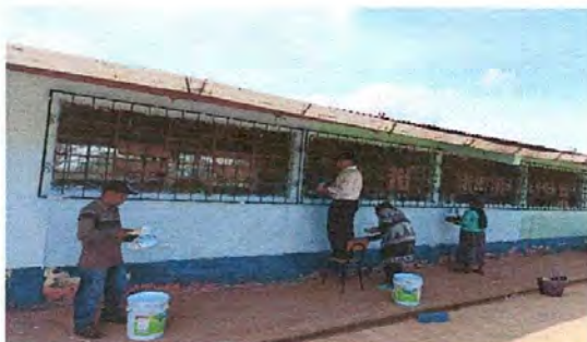
Foto 3: Proceso de aplicación de pintura
