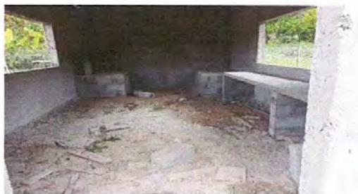
Foto 6: Estufas rurales en proceso de instalación
