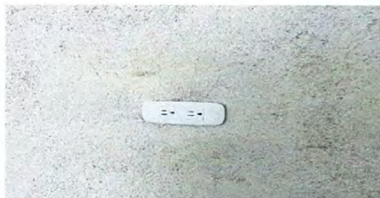
Foto 5: Sistema eléctrico en proceso de instalación
