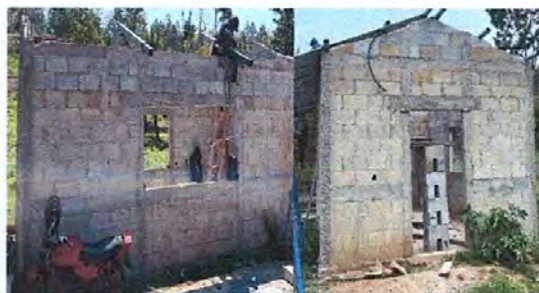
Foto 8: Proceso de mejoramiento pared cocina
