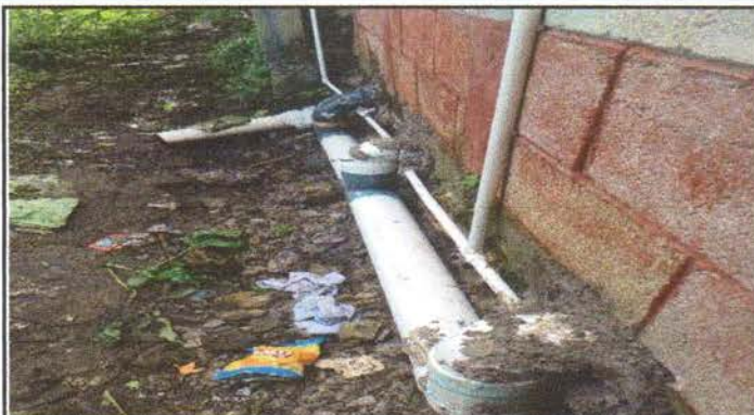
Foto 1: Sustrucción de tubería de agua y drenaje.
