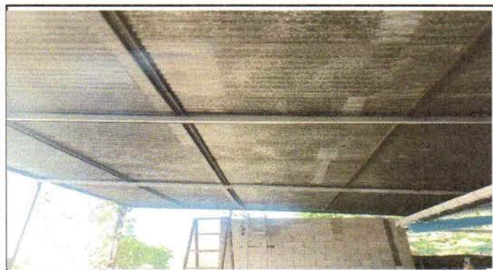
Foto 3: Mantenimiento de estructura de soporte de metal
