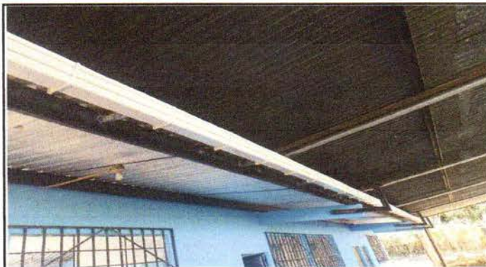
Foto 2: Sustitución de canales para agua pluvial
