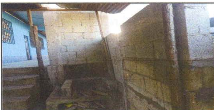
Foto 3: Culminación y levantado de 5 hiladas de block en una parte de la cocina.
