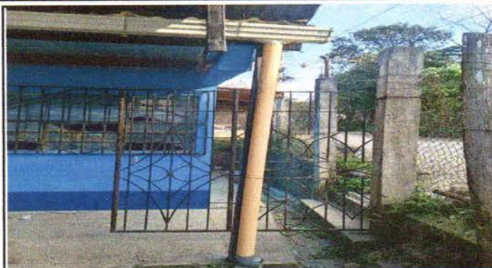
Foto 1: Sustitución de canales para agua pluvial
