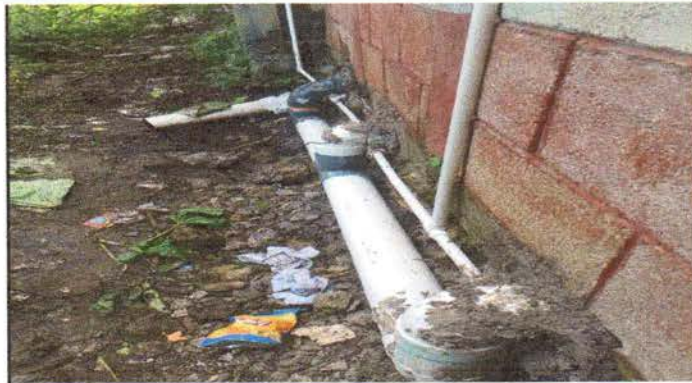
Foto 2: Sustitución de tubería de agua y drenaje.
