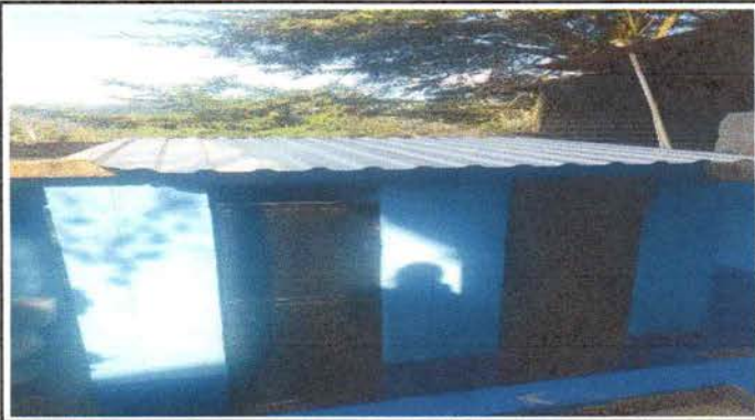
Foto 2: Cambio de techo de lamina por lamina troquelada calibre 26
