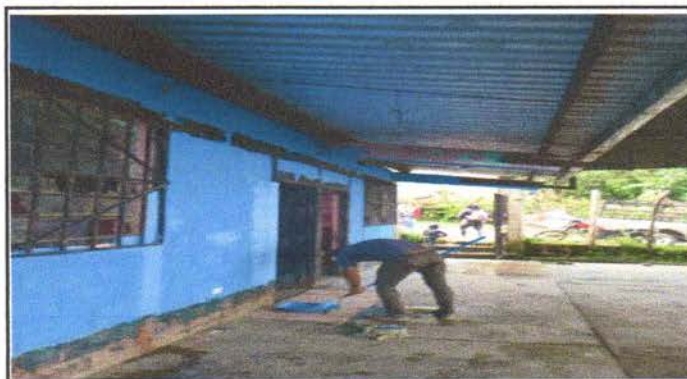
Foto 4: Pintura para muros exteriores e interiores de toda la escuela.
