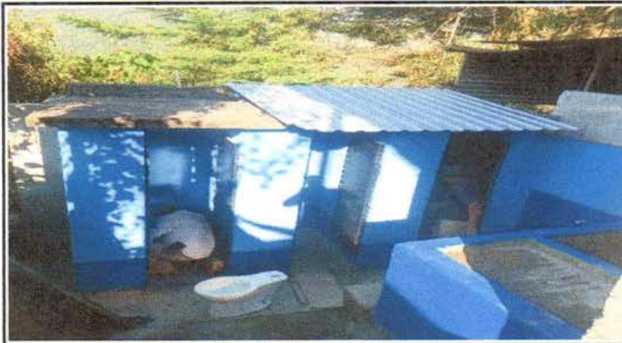
Foto 1: Cambio de techo de lamina por lamina troquelada calibre 26
