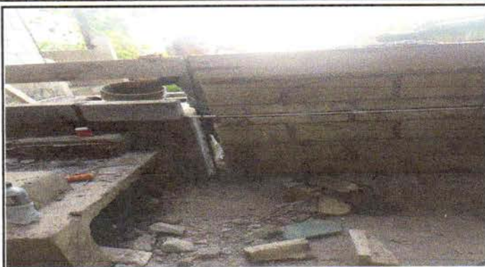
Foto1: Sustitución de tubería de agua y drenaje.
