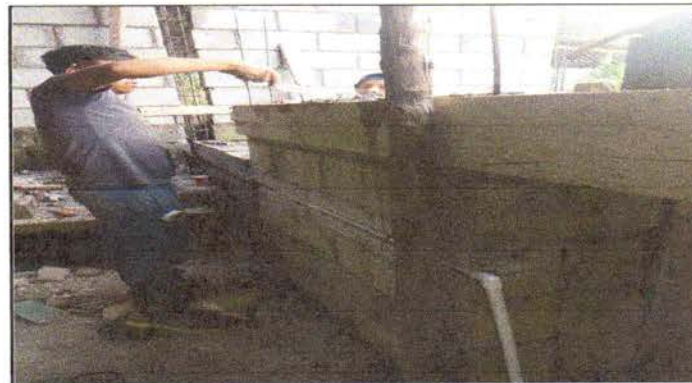
Foto 4: Culminación y levantado de 5 hiladas de block en una parte de la cocina.
