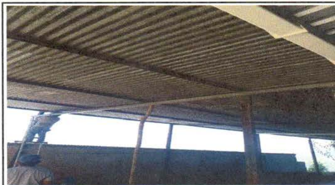
Foto 3: Mantenimiento de estructura de soporte de metal
