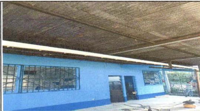
Foto 4: Mantenimiento de estructura de soporte de metal
