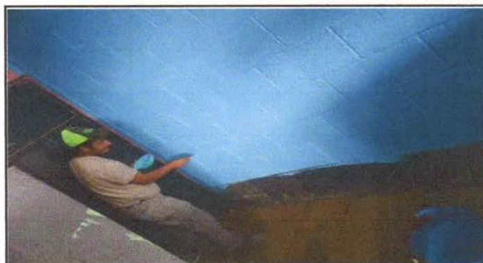
Foto 3: Pintura para muros exteriores e interiores de toda la escuela.
