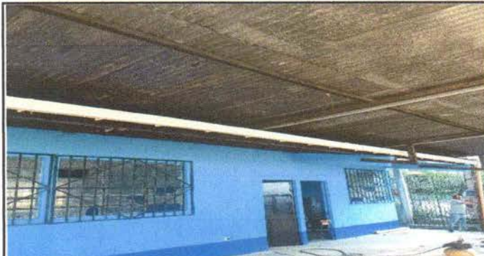
Foto 2: Sustitución de canales para agua pluvial
