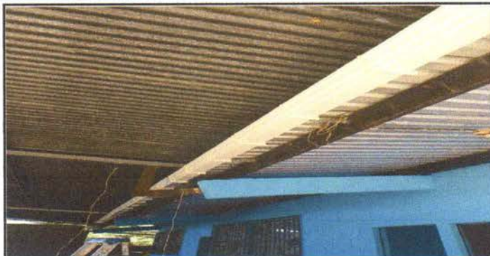
Foto 1: Sustitución de canales para agua pluvial
