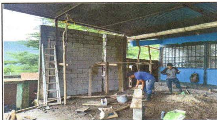
Foto 3: Culminación y levantado de 5 hiladas de block en una parte de la cocina.
