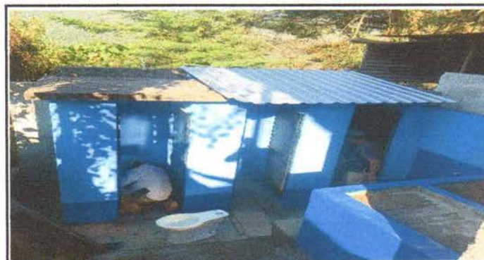
Foto 6: Instalación de 3 inodoros de porcelana tamaño grande y sus accesorios.
